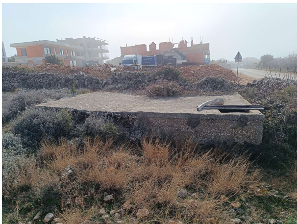
Fotografija 1 – cisterna u južnom kutu predmetne čestice
