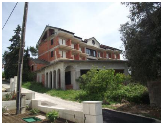
Sjeverozapadno i jugozapadno pročelje
