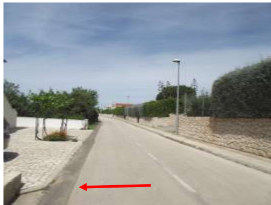
Pristupna cesta sa sjeverne strane
