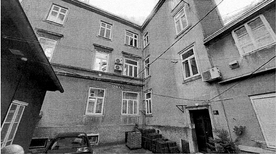
pogled na zgradu i stan
