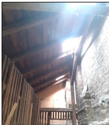
Tavanski prostor potkrovlja, na kojem se vide rogovi i daščana oplata.
