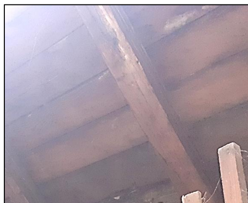
Tavanski prostor potkrovlja, na kojem se vide rogovi i daščana oplata.
