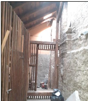
Tavanski prostor potkrovlja, na kojem se vide rogovi i daščana oplata.
