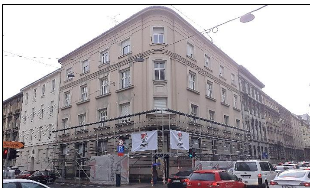
Početak radova: postavljanje fasadne skele.
