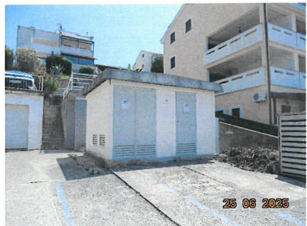
Sl.29) Kč.11591, trafostanica u ulici Japlenički put.
