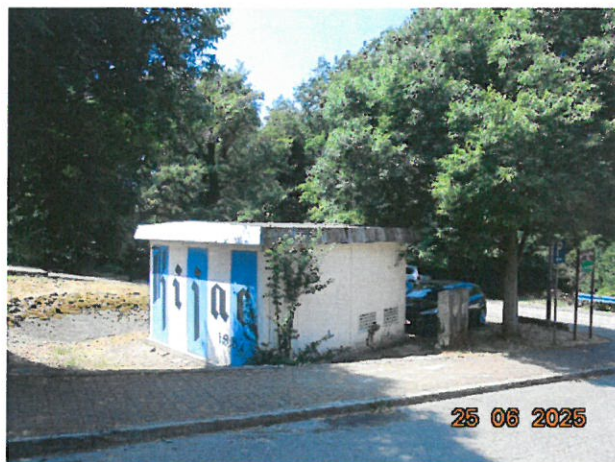
Sl.15) Kč.1497; trafostanica u ulici Stube put Kijca.
