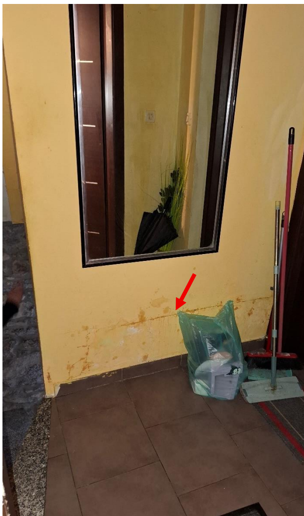
Slika 6. – zid prije puštanja vode u tušu
