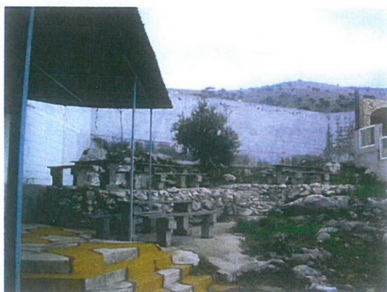
Betonirani plato uz sjevernu granicu
