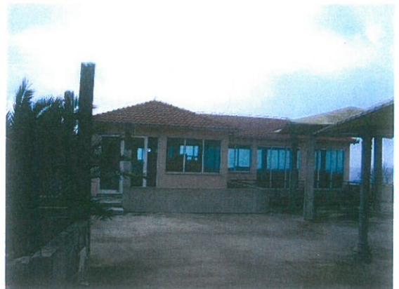
ulazno zapadno pročelje
