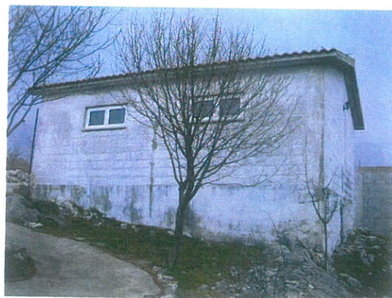
Istočno i sjeverno pročelje
