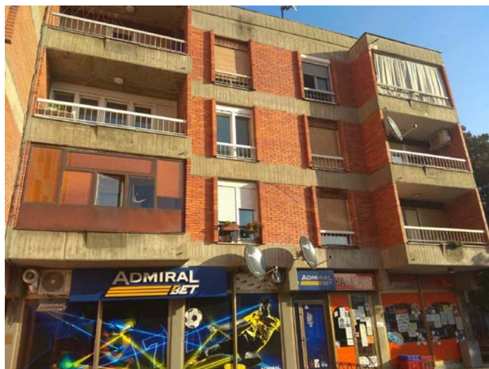
Pogled na zgradu sa juga
