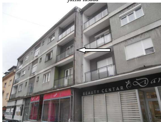
Stambeno poslovna zgrada, Priboj, ulica 12. januara broj 41-43, zapadna fasada
