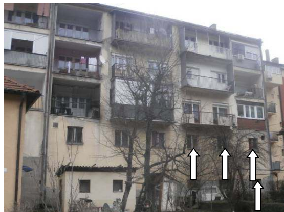
Stambeno poslovna zgrada, Priboj, ulica 12. januara broj 41-43, južna fasada
