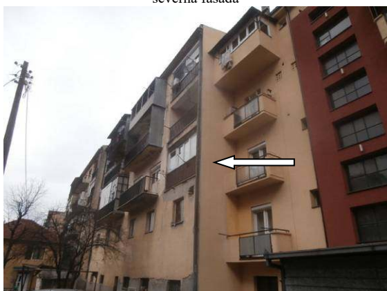
Stambeno poslovna zgrada, Priboj, ulica 12. januara broj 41-43, istočna fasada
