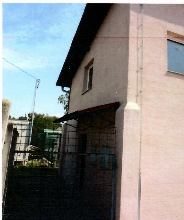
Zapadno pročelje objekta 1
