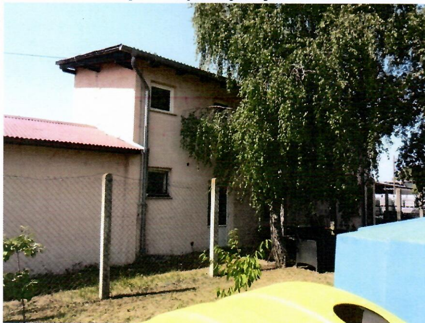
Sjeverno pročelje objekta 1
