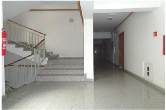
ulaz 2 - stubište za tavanski prostor
