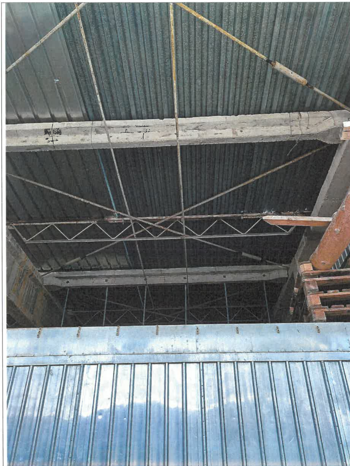
(sl. br. 41 – prikaz krovne konstrukcije; prvo polje sjeverne dilatacije u kojem je izveden horizontalni vjetrovni spreg čeličnim šipkama)
