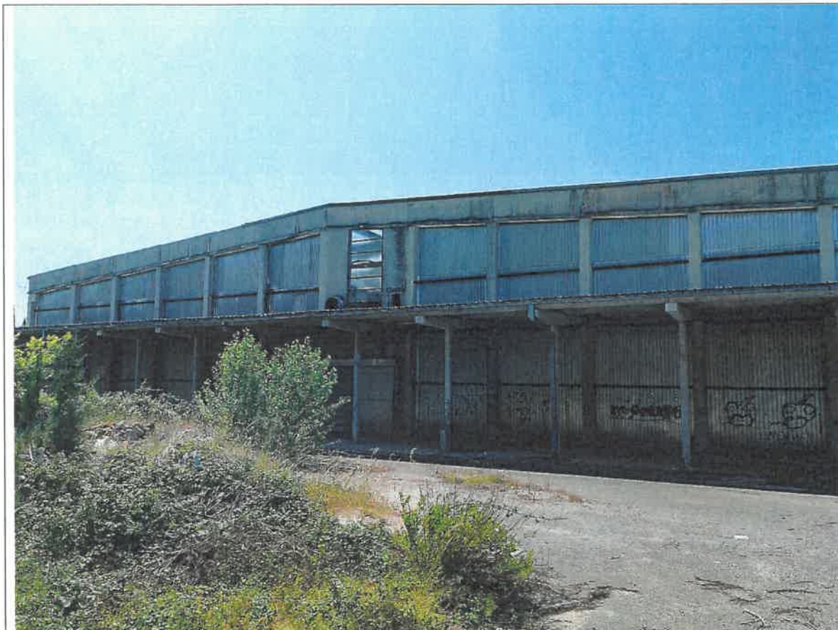
(sl. br. 4 – prikaz sjeverne fasade građevine)
