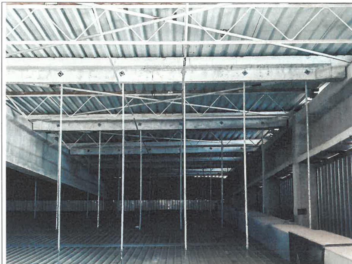
(sl. br. 36 – prikaz krovne konstrukcije; prvo polje južne dilatacije u kojem je izveden horizontalni vjetrovni spreg čeličnim šipkama)
