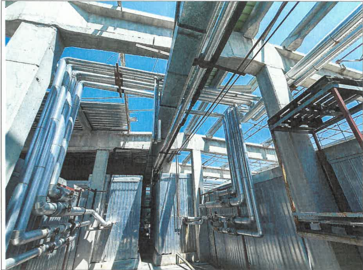
(sl. br. 40 – prikaz karakterističnog polja krovne konstrukcije u sjevernoj dilataciji)
