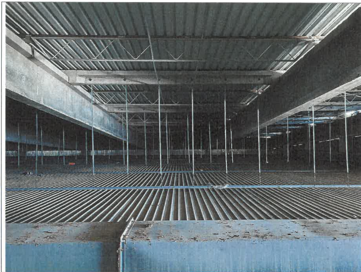
(sl. br. 38 – prikaz karakterističnog polja krovne konstrukcije u južnoj dilataciji)
