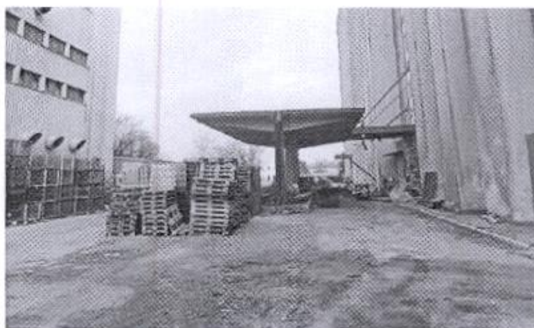
OBJEKT 6. , Kamionski prijem
