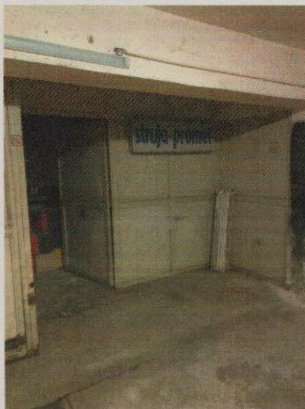
Slika 4. Pogled na ulaz u garaže
