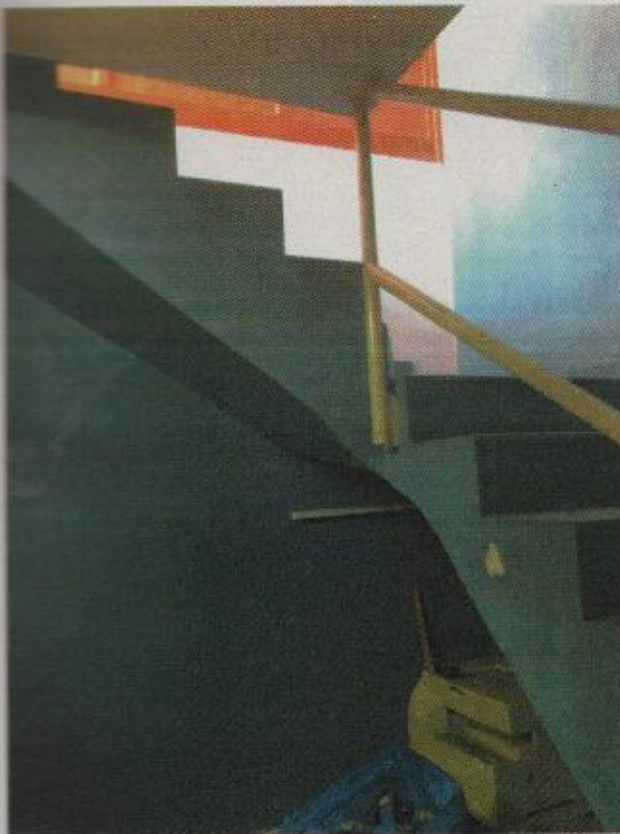
Slika 7. Pogled na stubište (veza podrum - prizemlje)
