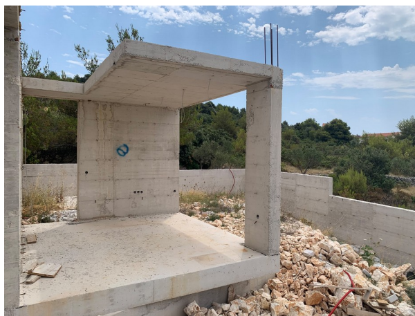
Natkrivena terasa, konstrukcija bez završne obrade
