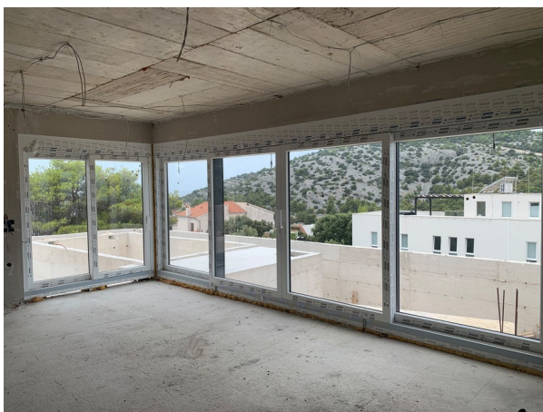
Prostorija u fazi grubih instalacija, ostakljeni ugao s pogledom na okolicu
