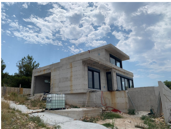
Pročelje objekta, P+1, ravni krov, gol beton bez fasade
