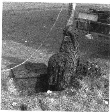
Vlažne maramice u kanalizacijskom kolektoru
