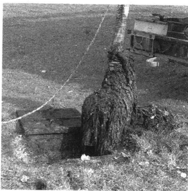
Vlažne maramice u kanalizacijskom kolektoru
