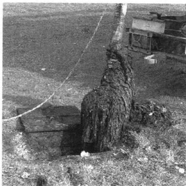
Vlažne maramice u kanalizacijskom kolektoru
