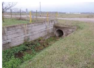
odvodni kanal i ogradni zid
