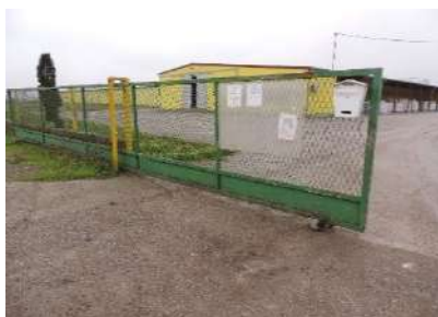
ulazna klizna rampa
