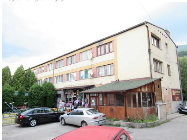
Pogled na zgradu i poslovni prostor s jugoistoka
