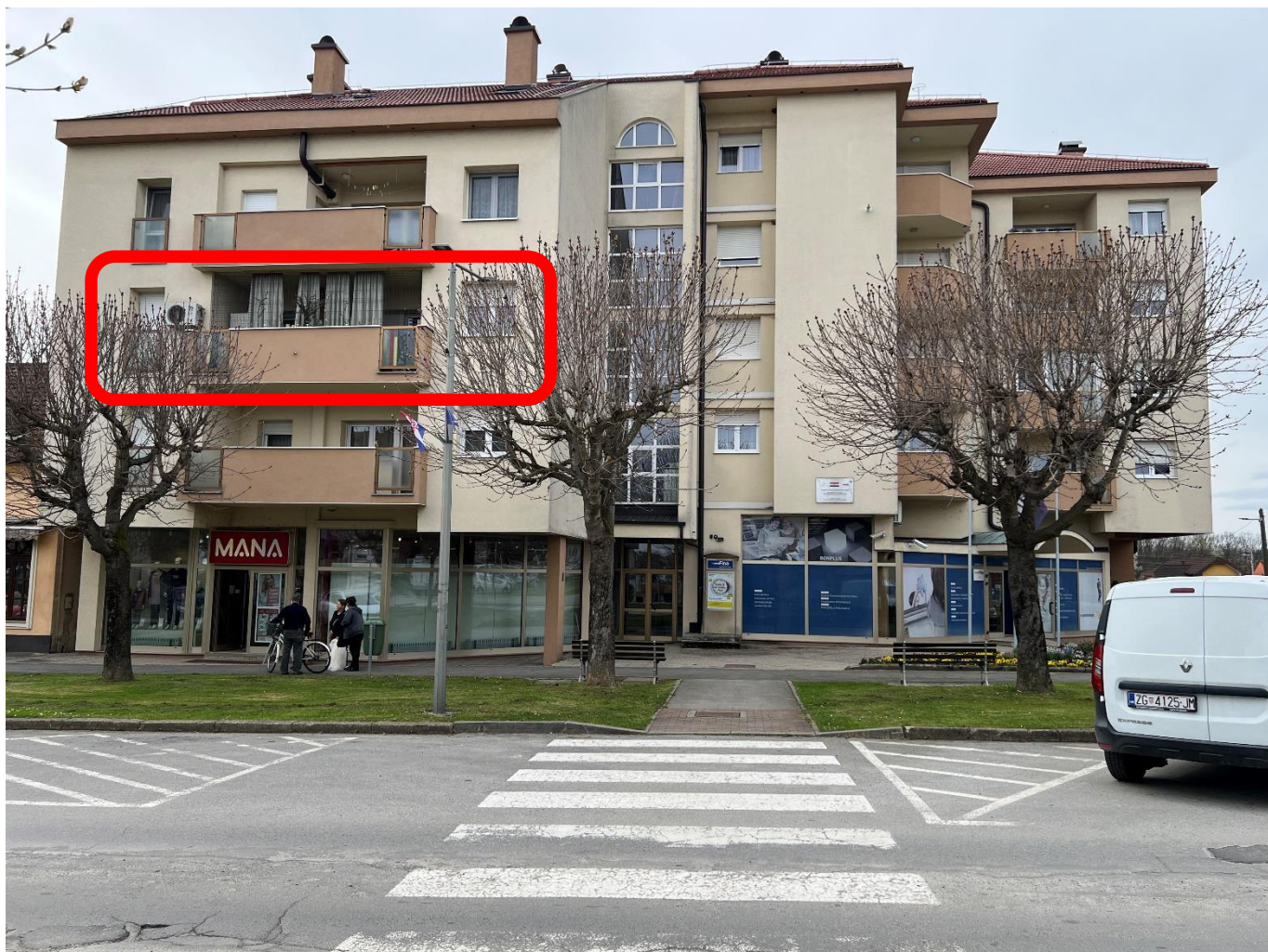
Pogled na zgradu
