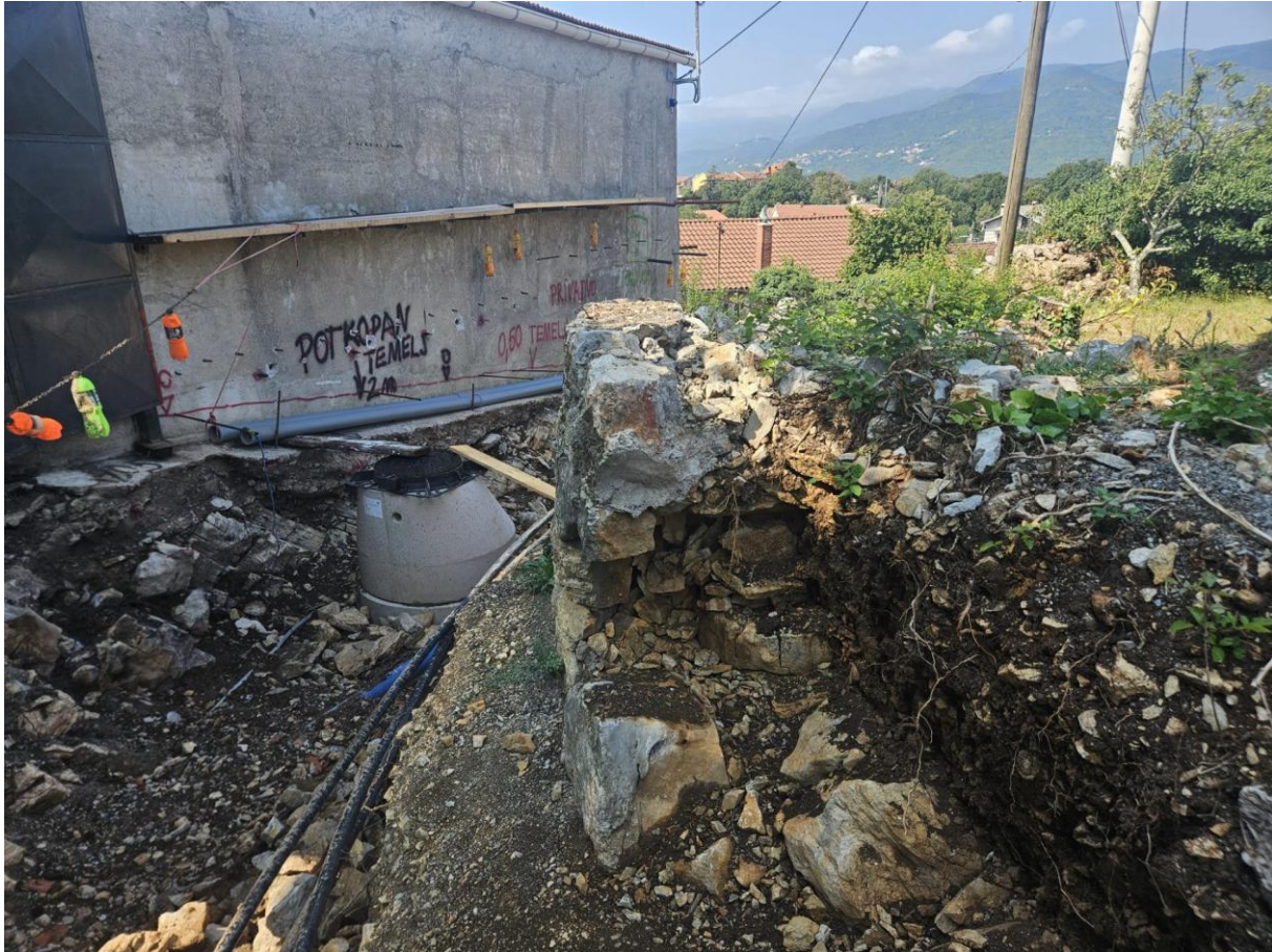
Slika 9 – Dodatno urušavanje, oštećenje i prepreke u području kanala.
