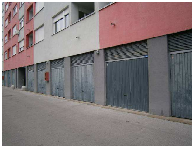
Foto 2: Zgrada - garaže u prizemlju (studenj 2014.)
