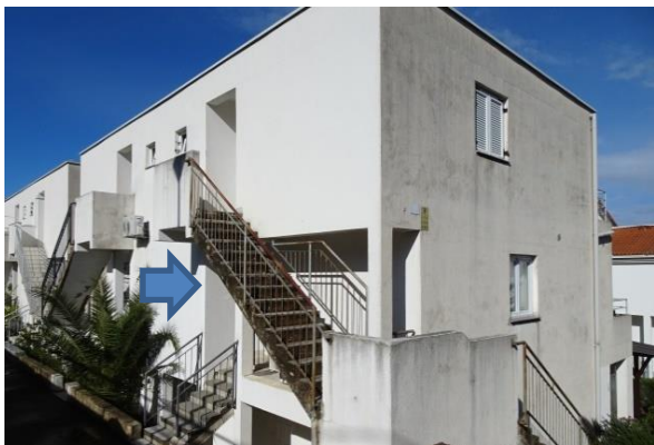
Vanjsko stubište i pročelje
