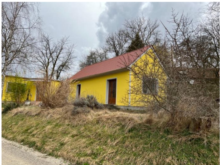
Slika 6.: Pročelje stambene zgrade
