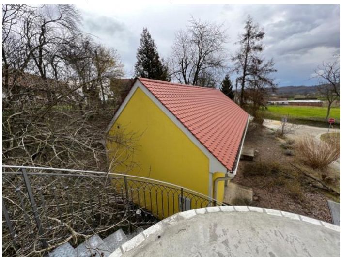
Slika 8.: Pročelje stambene zgrade
