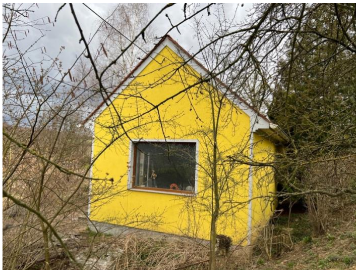
Slika 10.: Pročelje stambene zgrade
