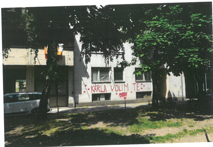
Predmetna stambeno-poslovska zgrada
