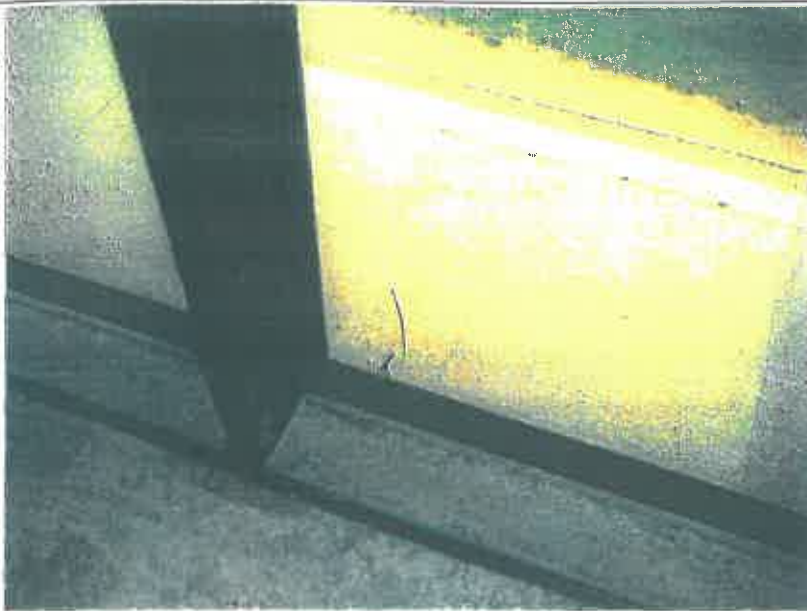
Puknuće stakla krovne kupole
