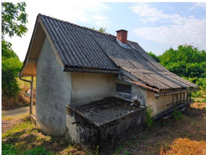
Slika 2: Pomoćna zgrada – klijet na k.č.br. 962/5, k.o. Vukosavljevica
