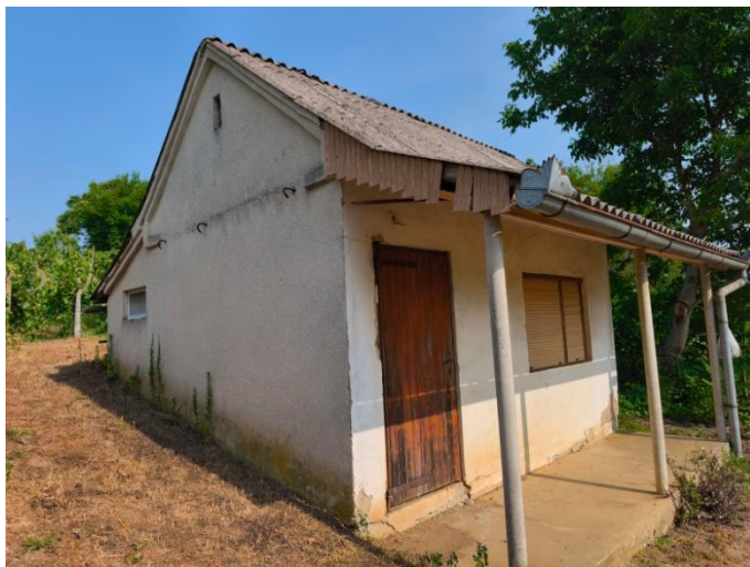
Slika 1: Pomoćna zgrada – klijet na k.č.br. 962/5, k.o. Vukosavljevica
