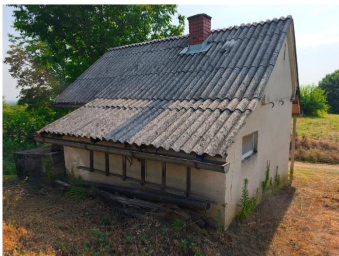
Slika 3: Pomoćna zgrada – klijet na k.č.br. 962/5, k.o. Vukosavljevica
