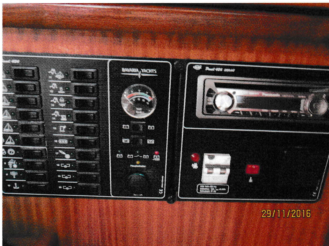
Slika 3: Razvodna ploča i radio
