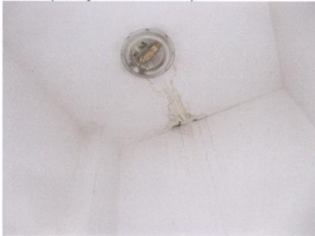
Sanitarni čvor južni – vlaga u blizini električnih instalacija
