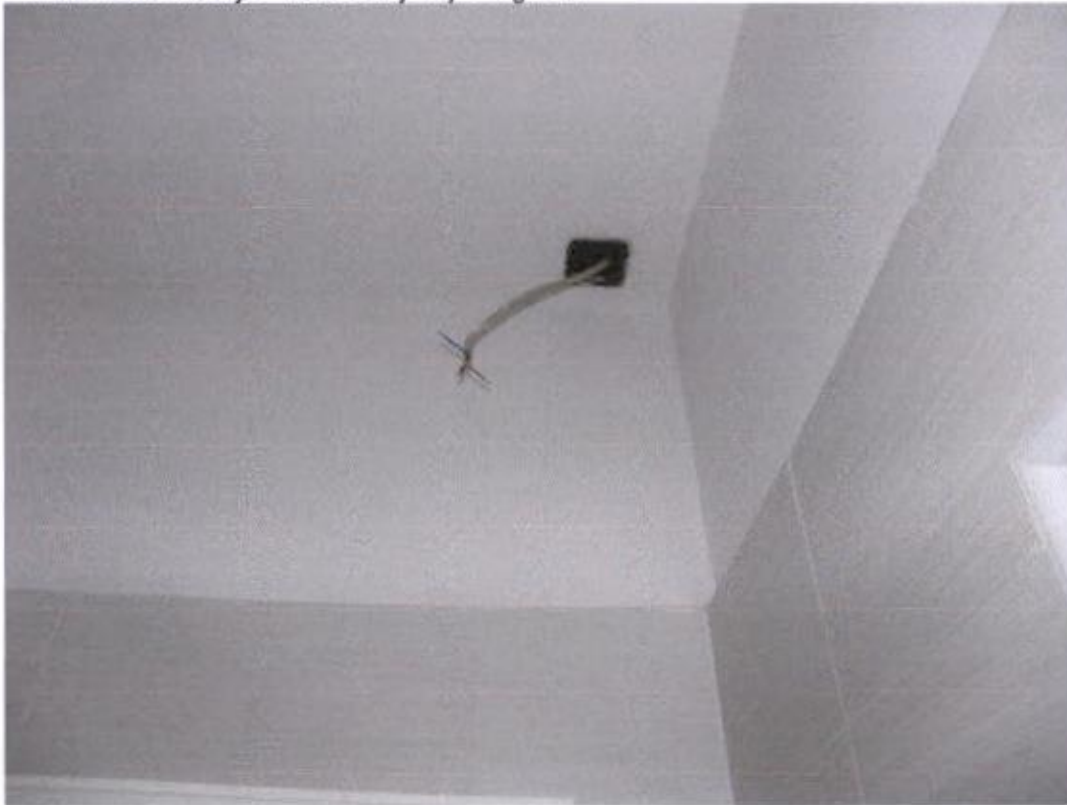
Sanitarni čvor kuhinje – izvod struje nije osiguran
