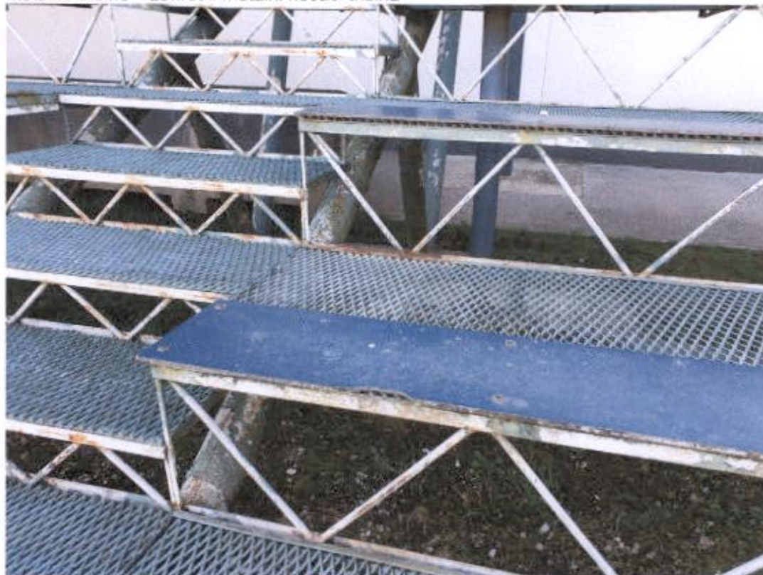
Metalne tribine – zahrđali metalni nosači tribina
