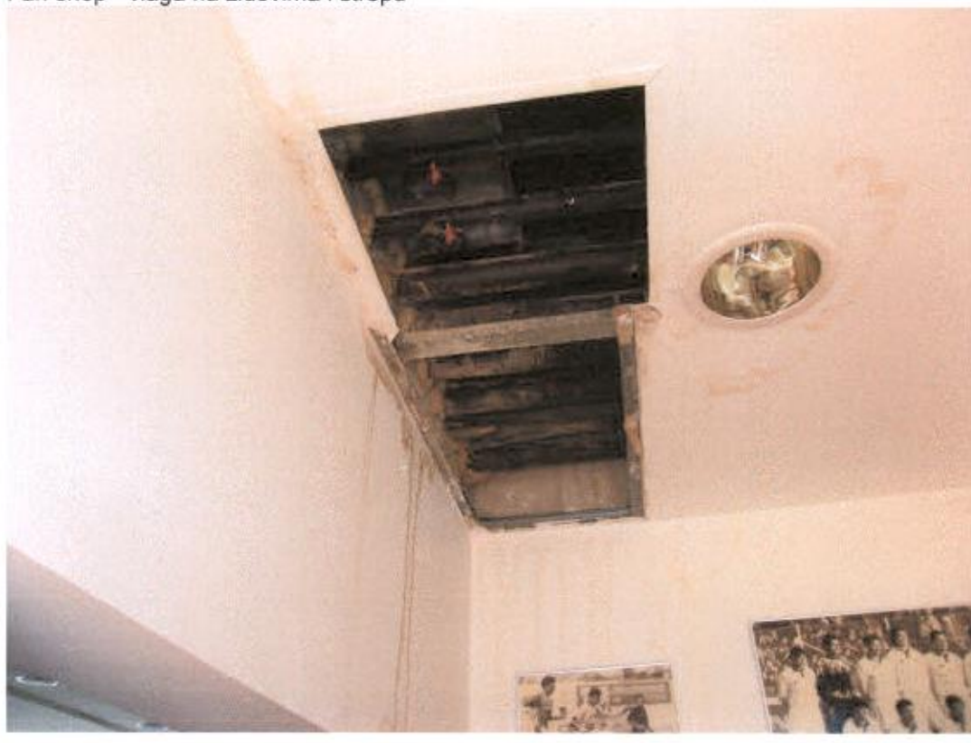
Fan shop - vlaga na zidovima i stropu
