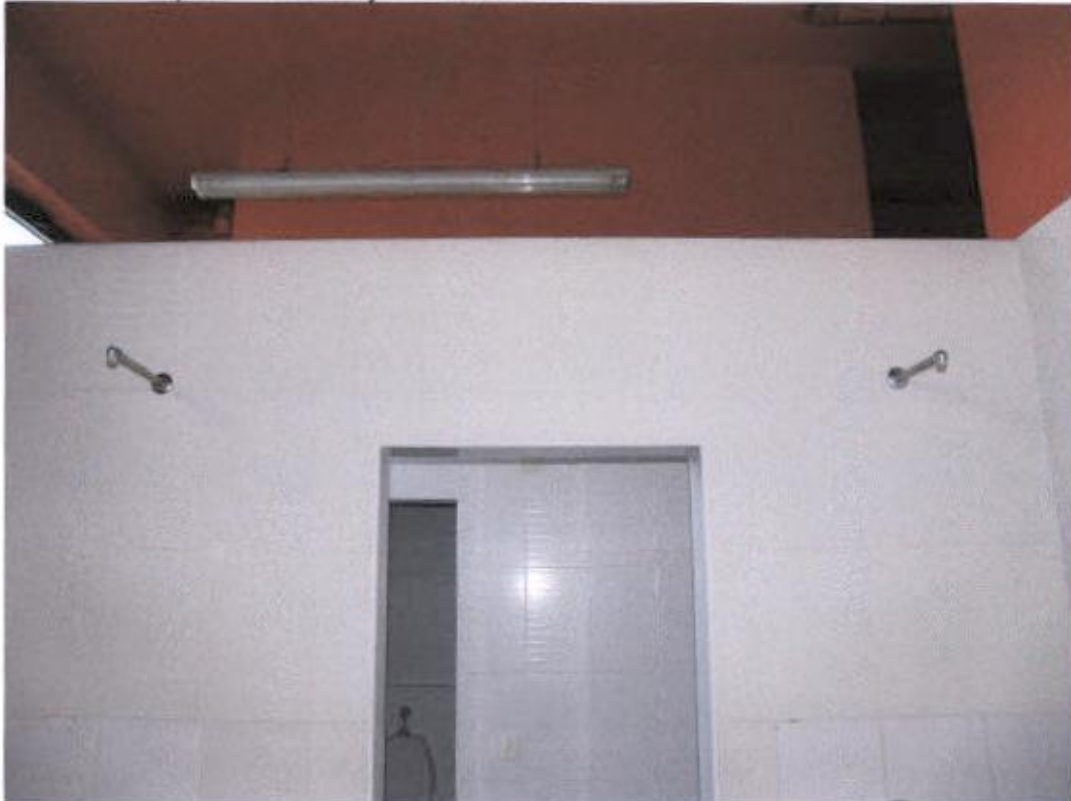
Svlačionica – pioniri – nedostaju ruže na tuševima
