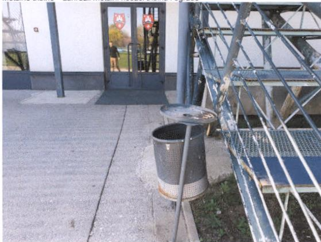
Metalne tribine – zahrđali metalni nosači tribina i ograde
