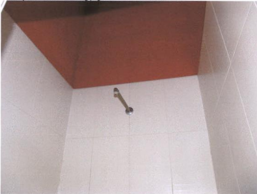
Prostorija trenera omladinskog pogona nema rozete na tušu
