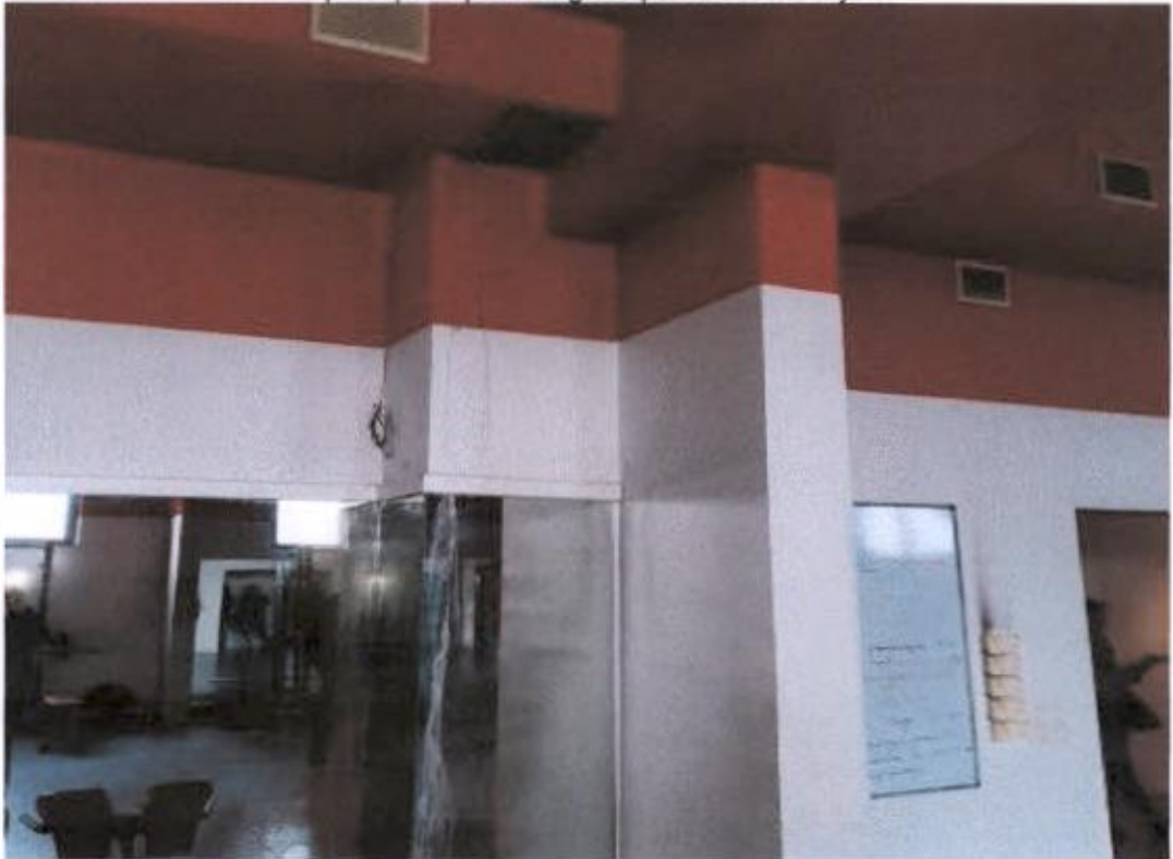
Fitness dvorana – nema poklopca spuštenog stropa kod ventilacije
