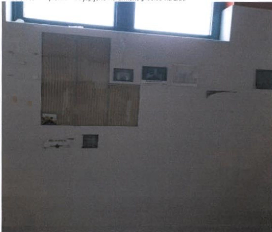
Svlačionica 4 – pioniri – odljepljene keramičke pločice na zidu
