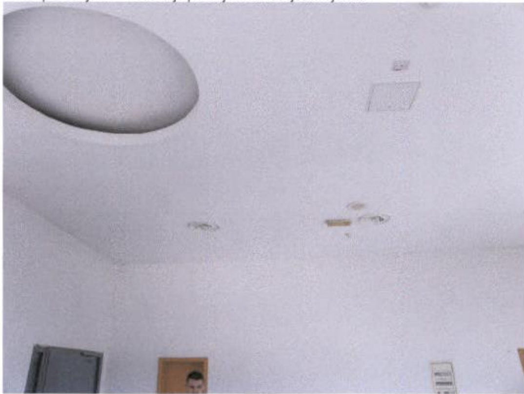
Ulazni prostor južni – nedostaju plafonjere na rasvjetlim tijelima
