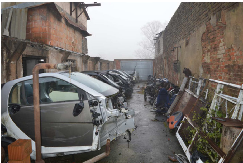
Pogled na unutrašnjost zgrade Pilane na k.č.br. 52/6 ( nenatkriveni dio)
