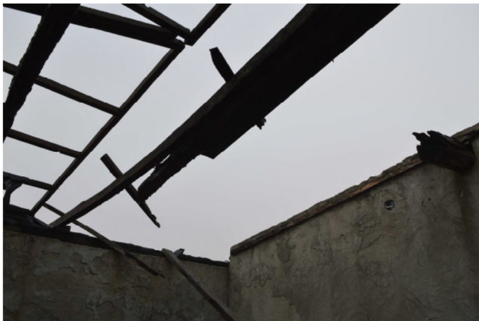
Pogled na ostatke krova zgrade Pilane na k.č.br. 52/6
