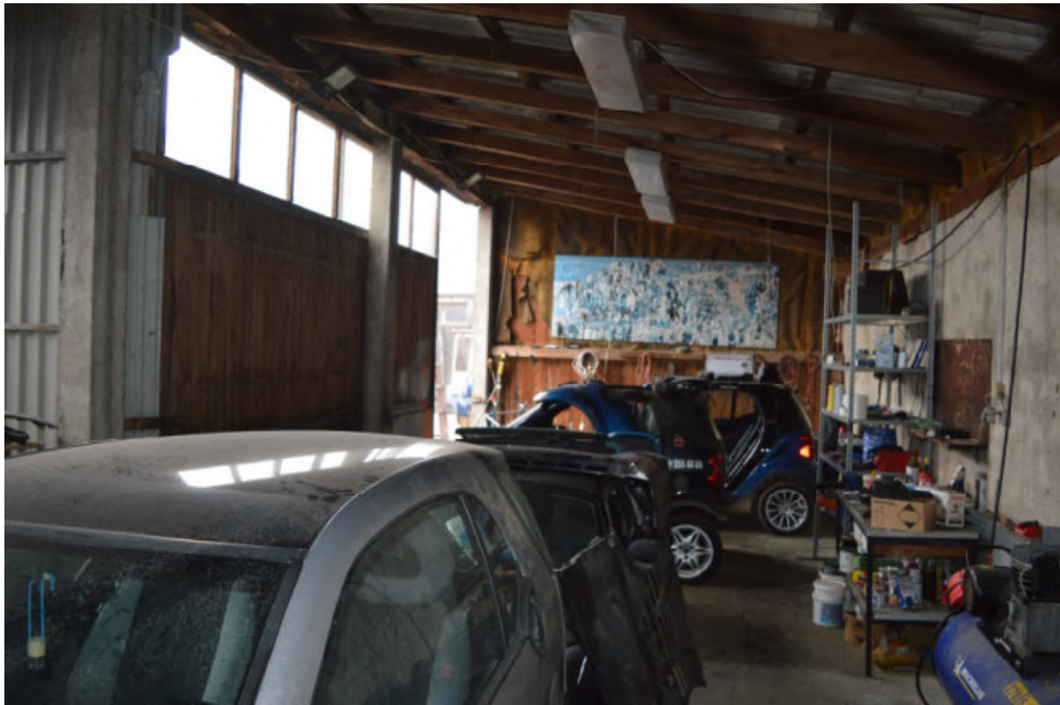
Pogled na unutrašnjost zgrade Pilane na k.č.br. 52/6 ( natkriveni dio)
