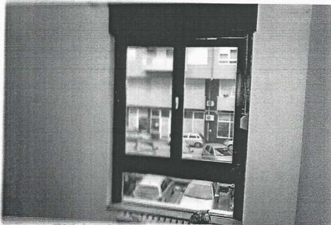
stari drveni prozor sa dvostrukim IZO staklom
