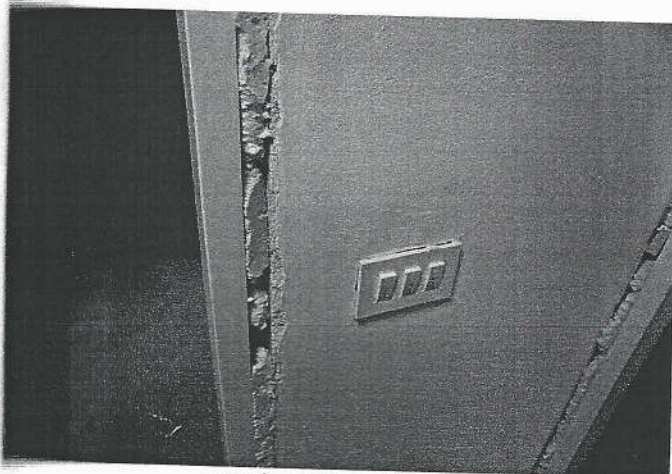
ugrađene nove sklopke
