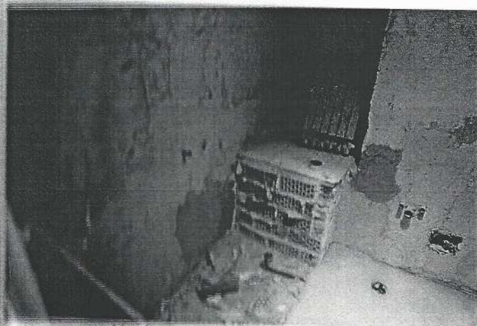
uklonjeni sanitarni predmeti i radijator
