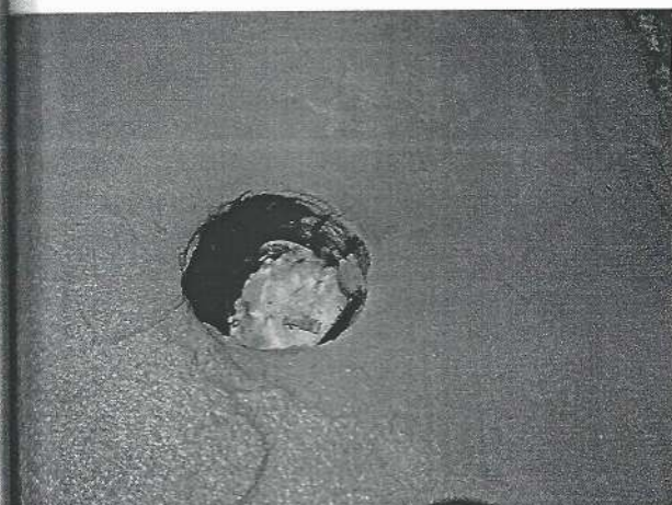
podni sifon u kupaonici zaštopan mortom
