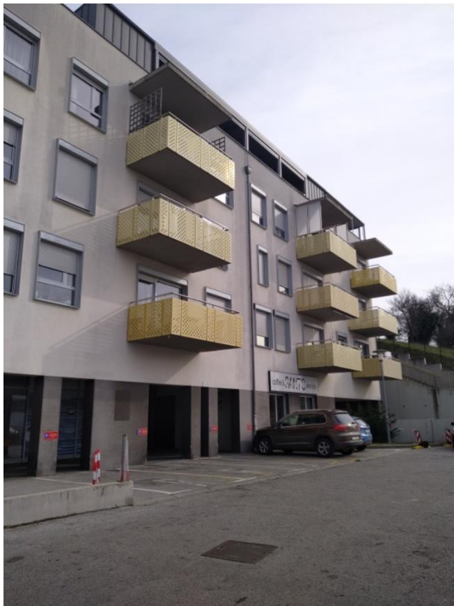
Slika 1. Vanjski izgled zgrade
