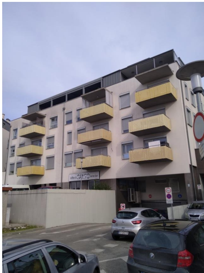
Slika 2. Ulaz u garažu
