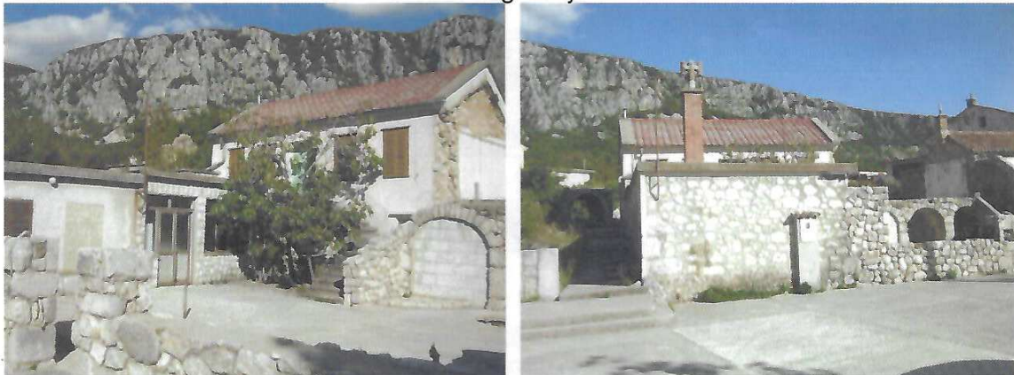
Stambeni dio nekretnina – stara kuća s dogradnjom
