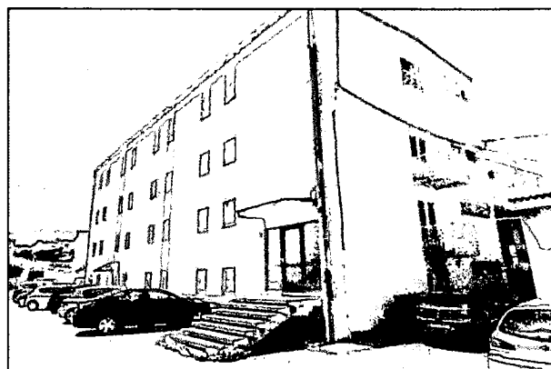
južno i istočno pročelje
