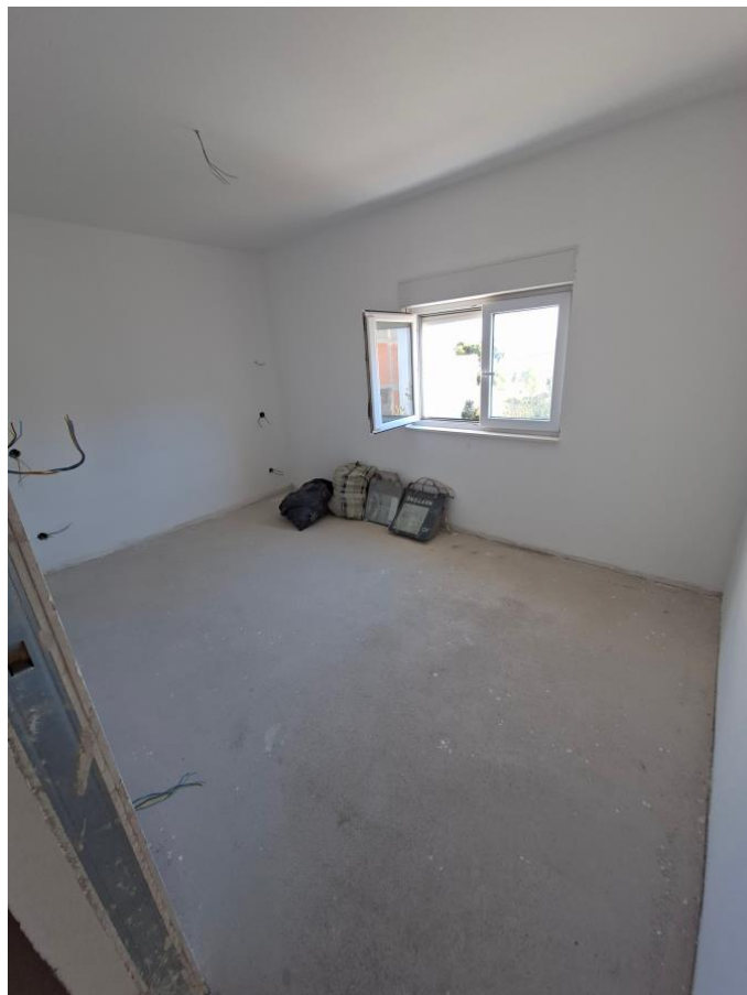
Fotografija 13 – unutrašnjost zgrade / 1. kat
