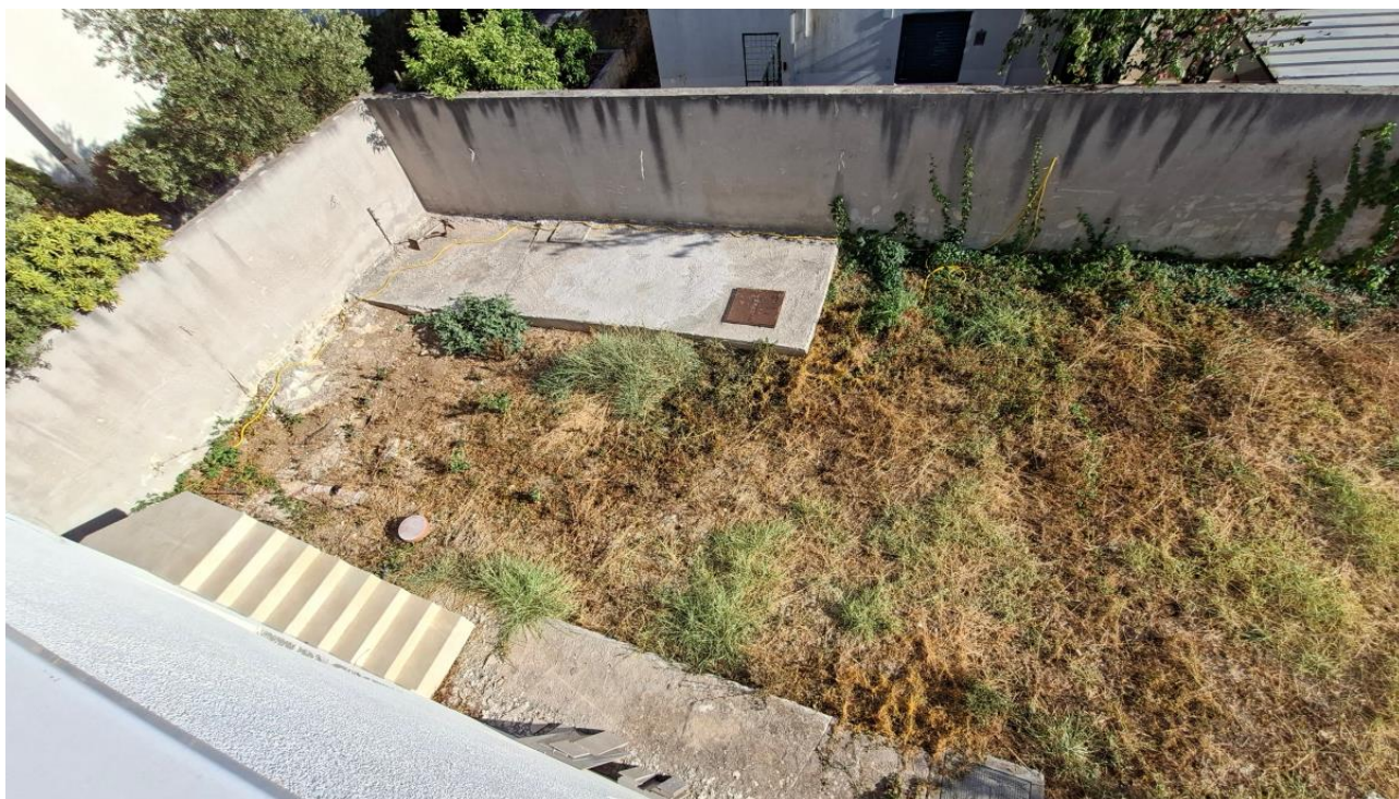
Fotografija 38 – okoliš zgrade
