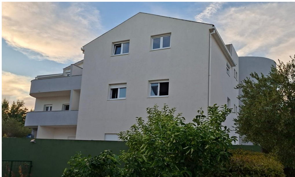
Fotografija 3 – predmetna zgrada
