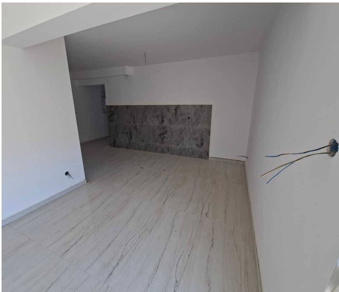
Fotografija 20 – unutrašnjost zgrade / 1. kat
