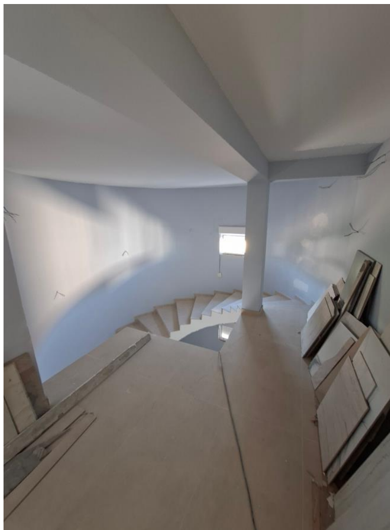
Fotografija 36 – unutrašnjost zgrade / 2. kat
