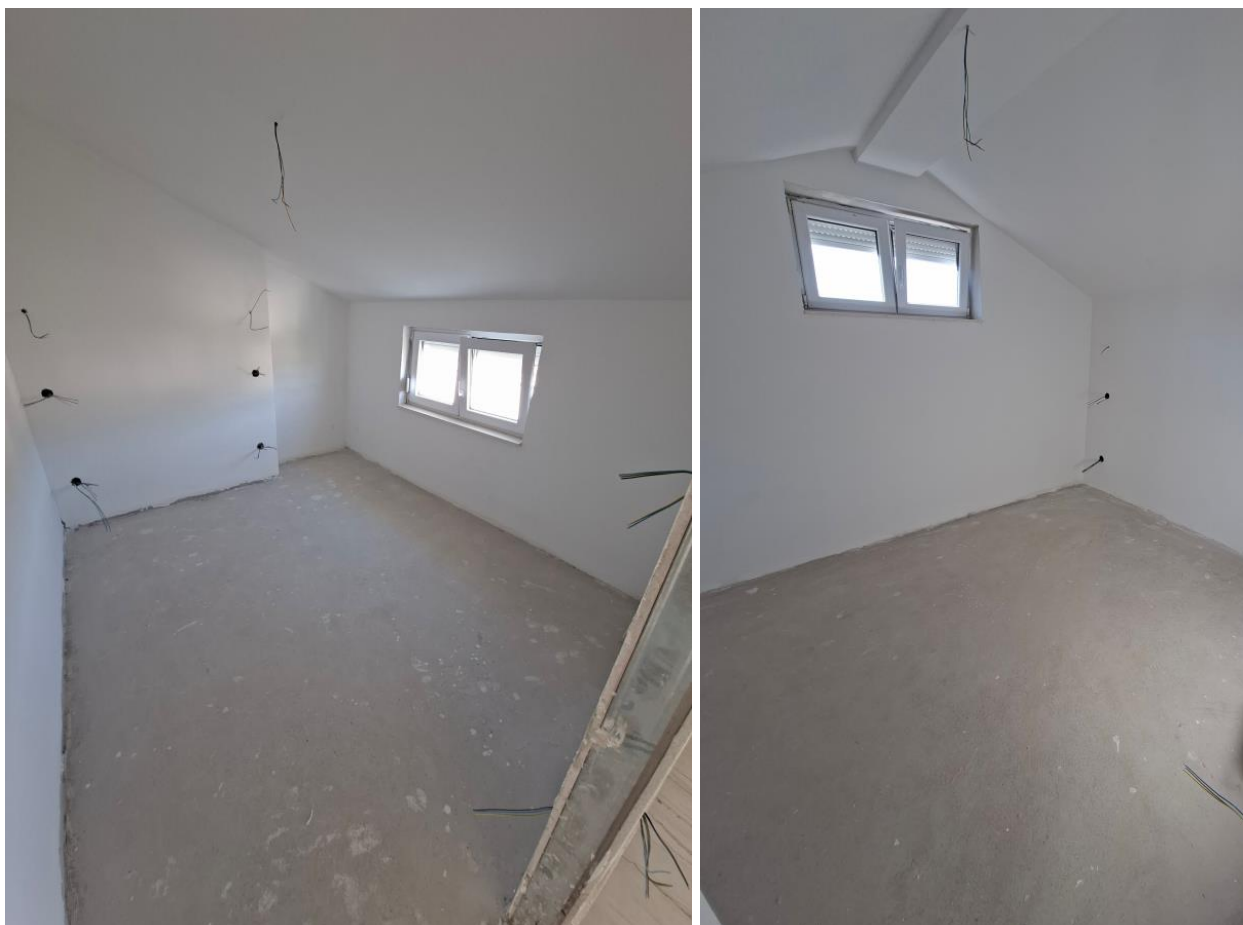
Fotografija 32 – unutrašnjost zgrade / 2. kat
