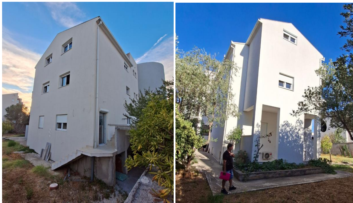
Fotografija 2 – predmetna zgrada
