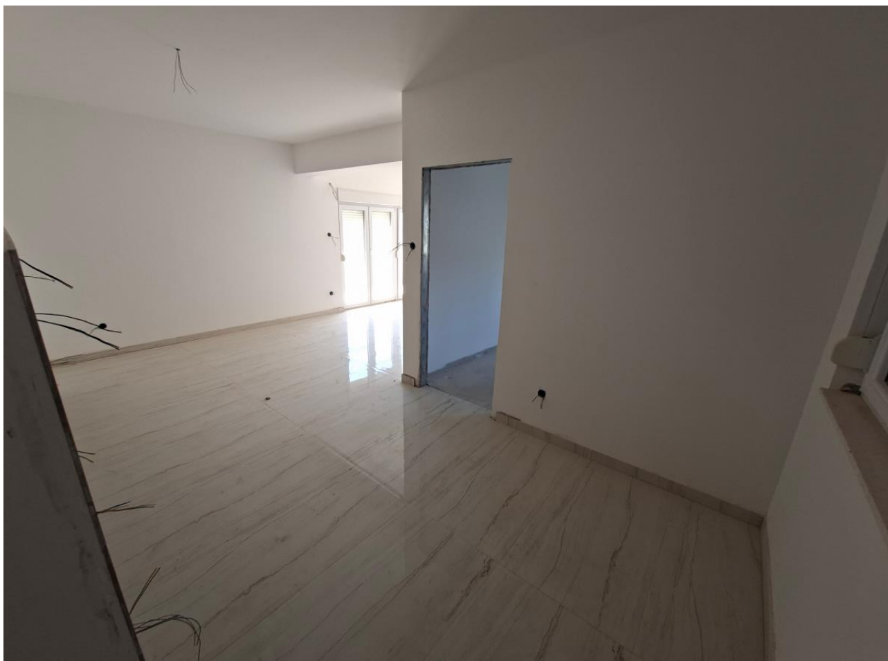
Fotografija 18 – unutrašnjost zgrade / 1. kat
