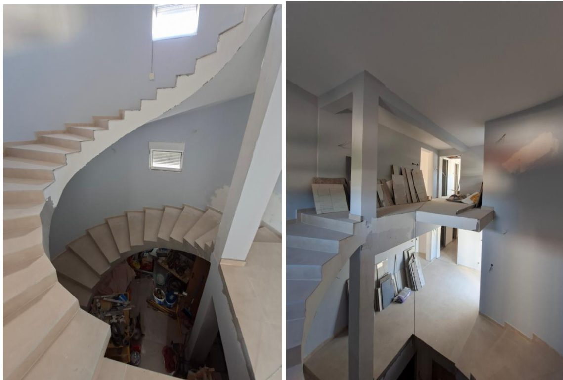
Fotografija 21 – unutrašnjost zgrade / stubište od 1. kata do 2. kata
