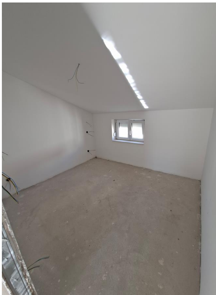
Fotografija 26 – unutrašnjost zgrade / 2. kat
