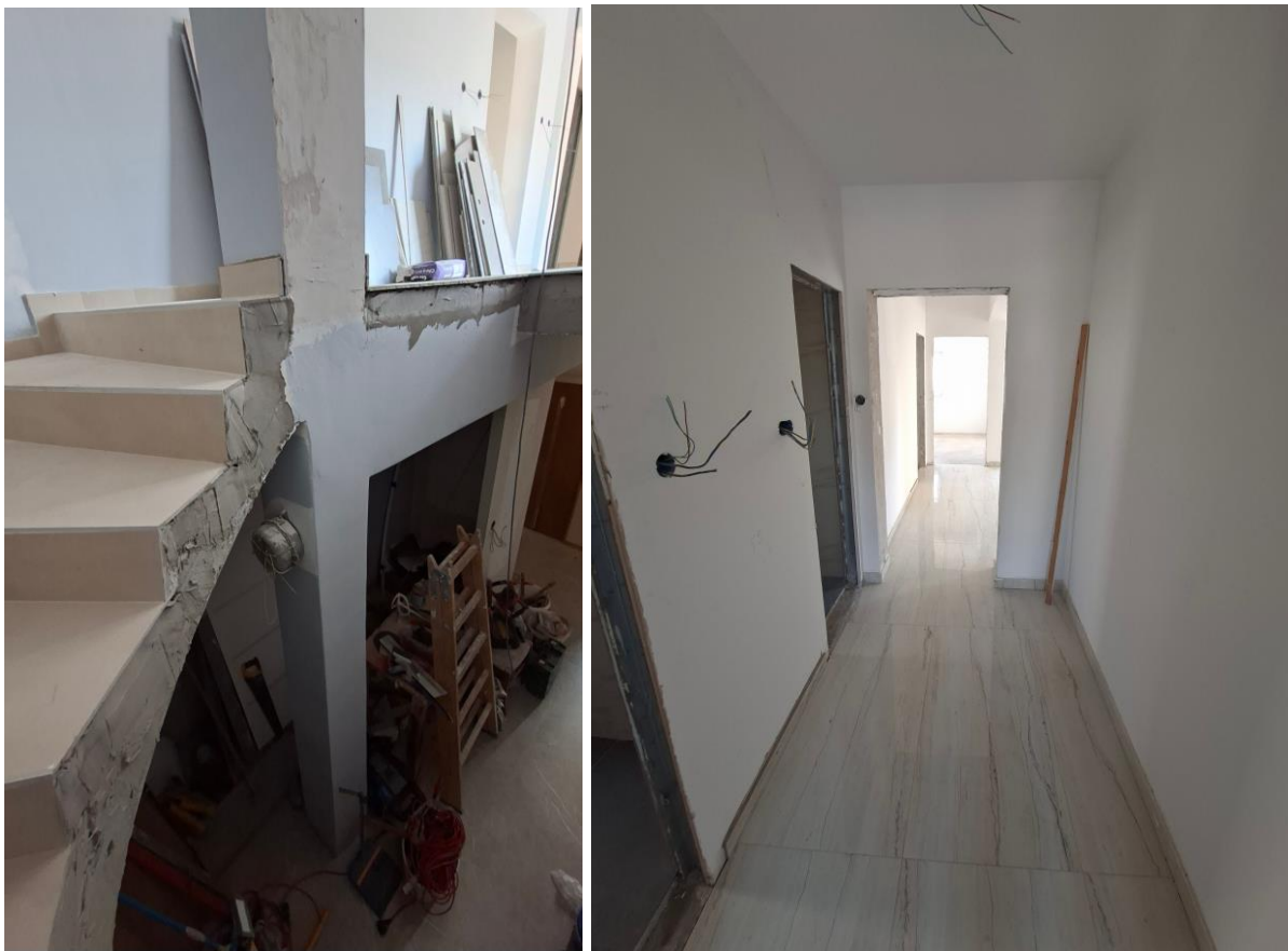
Fotografija 10 – unutrašnjost zgrade / 1. kat
