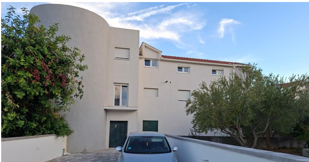
Fotografija 5 – predmetna zgrada
