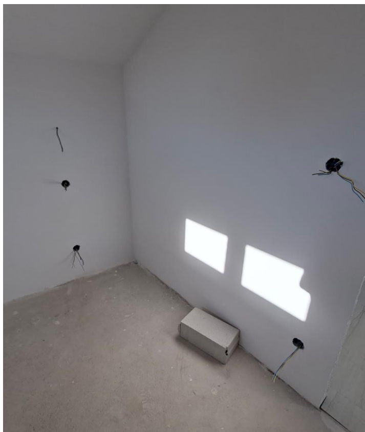
Fotografija 34 – unutrašnjost zgrade / 2. kat
