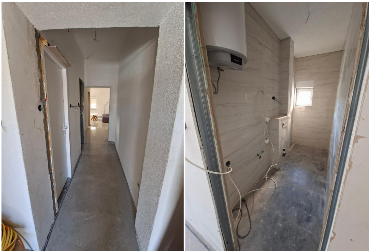
Fotografija 6 – unutrašnjost zgrade / prizemlje
