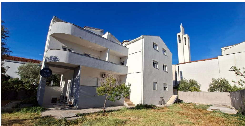
Fotografija 4 – predmetna zgrada
