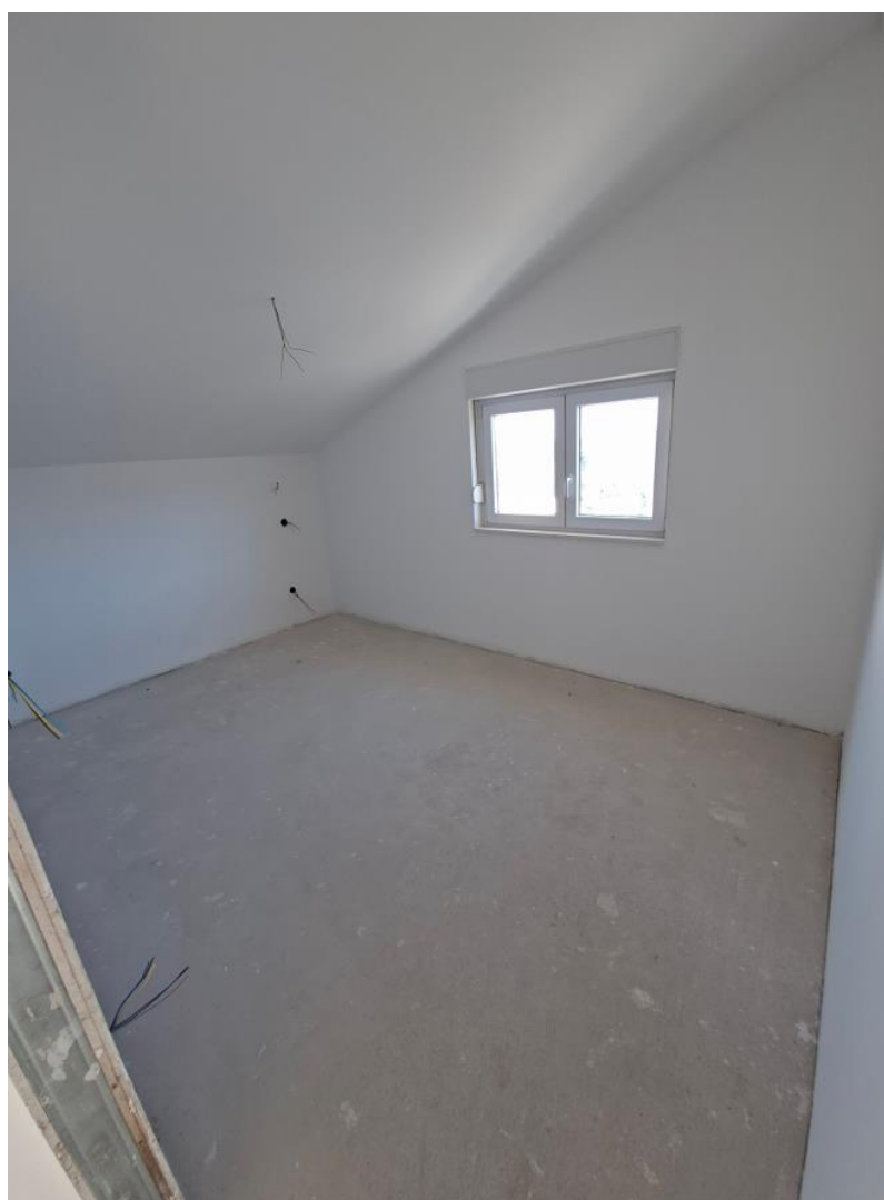
Fotografija 25 – unutrašnjost zgrade / 2. kat
