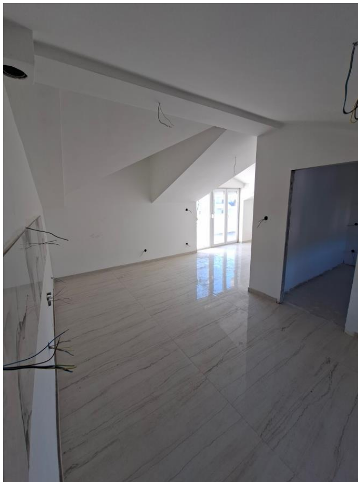
Fotografija 30 – unutrašnjost zgrade / 2. kat
