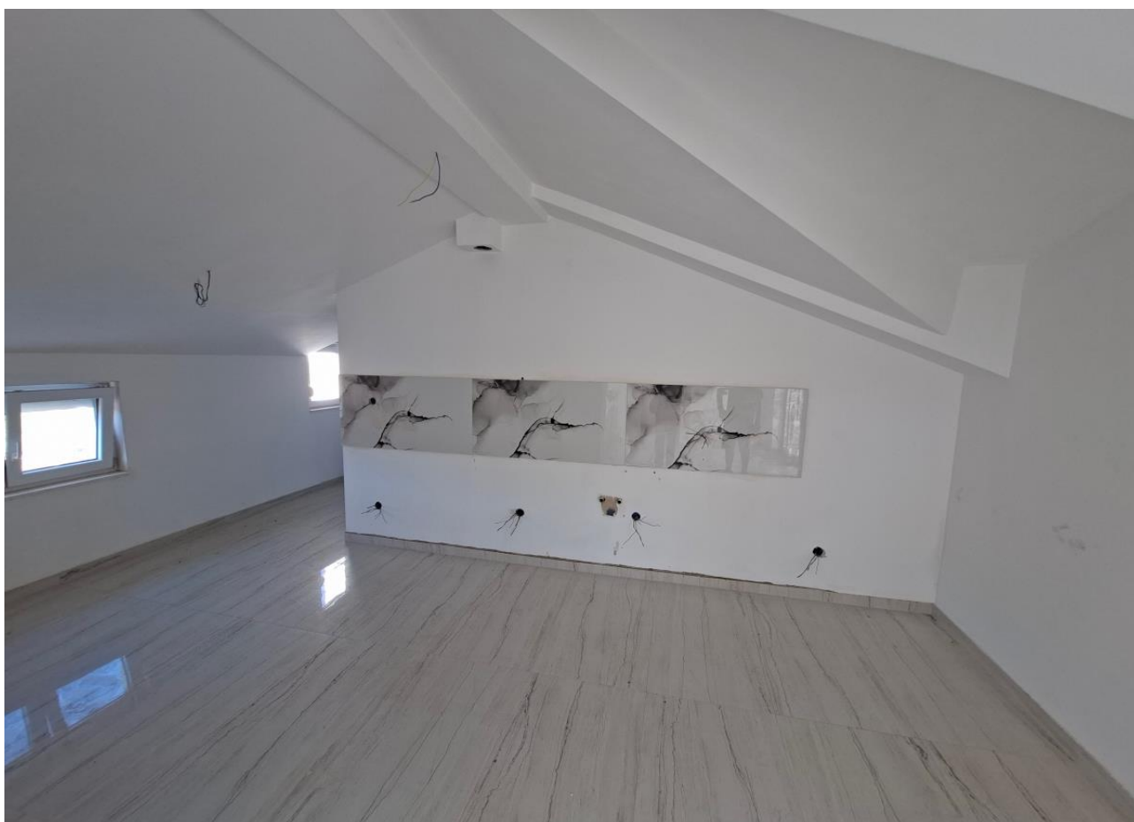
Fotografija 35 – unutrašnjost zgrade / 2. kat
