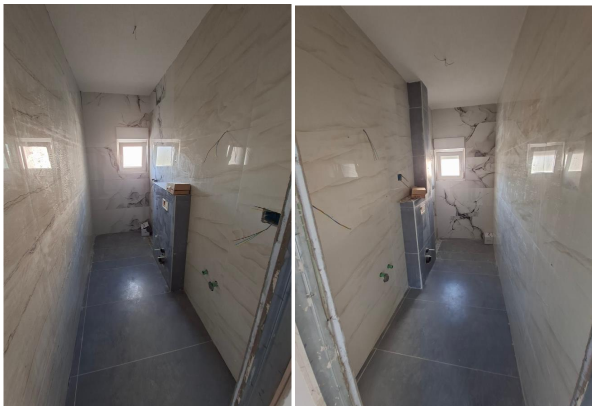
Fotografija 11 – unutrašnjost zgrade / 1. kat
