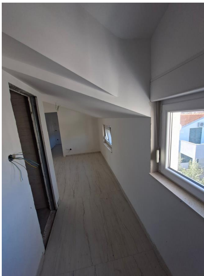
Fotografija 29 – unutrašnjost zgrade / 2. kat
