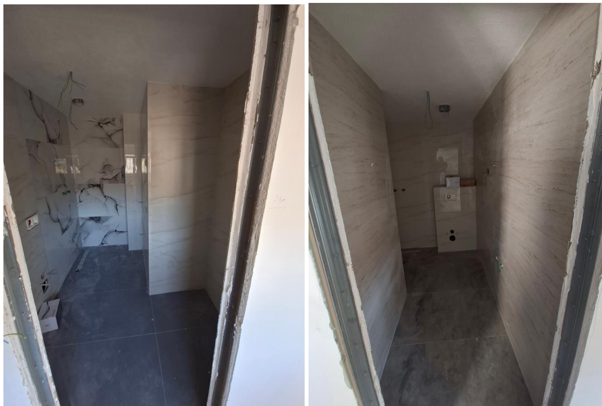
Fotografija 28 – unutrašnjost zgrade / 2. kat
