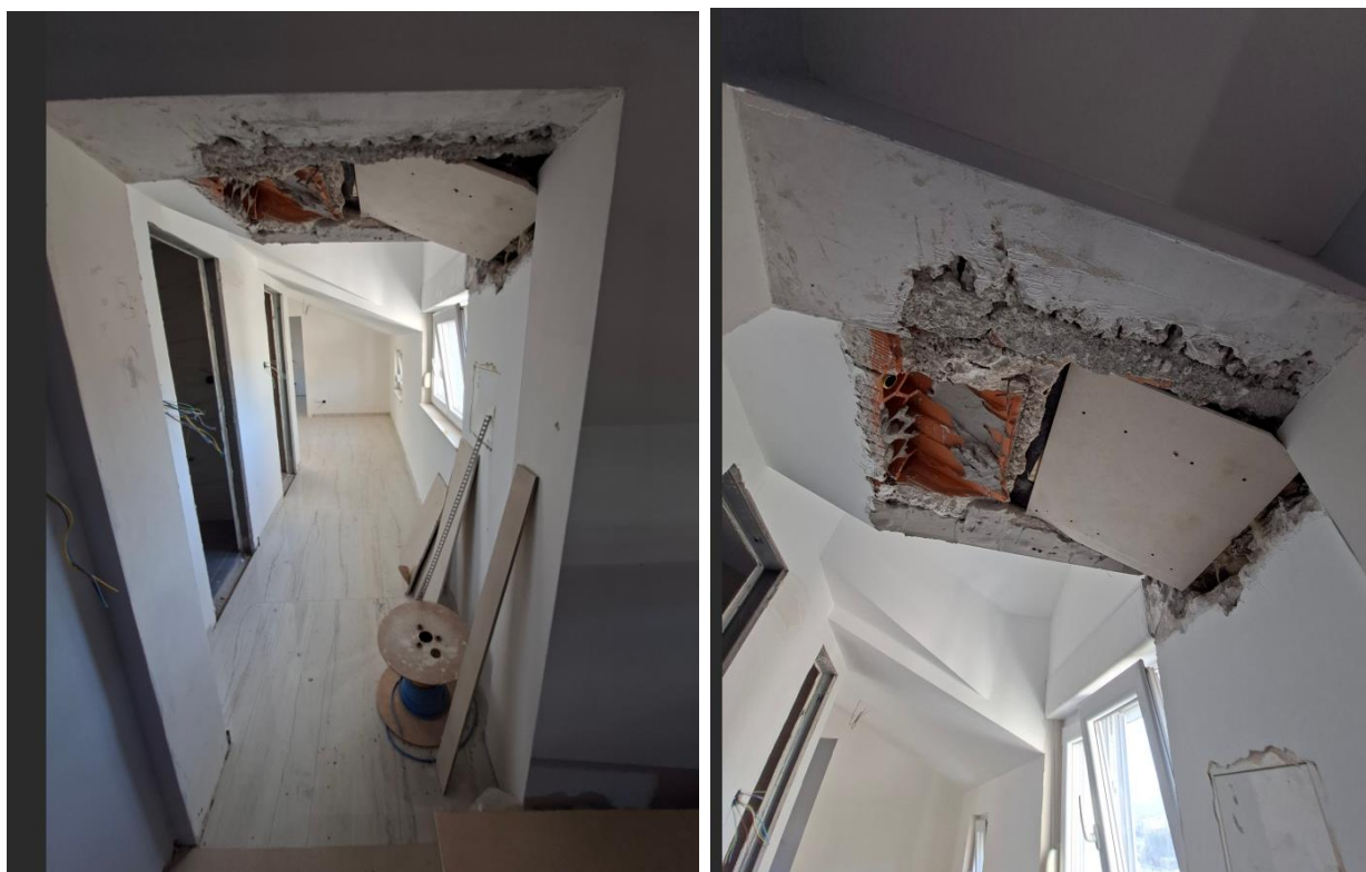
Fotografija 27 – unutrašnjost zgrade / 2. kat
