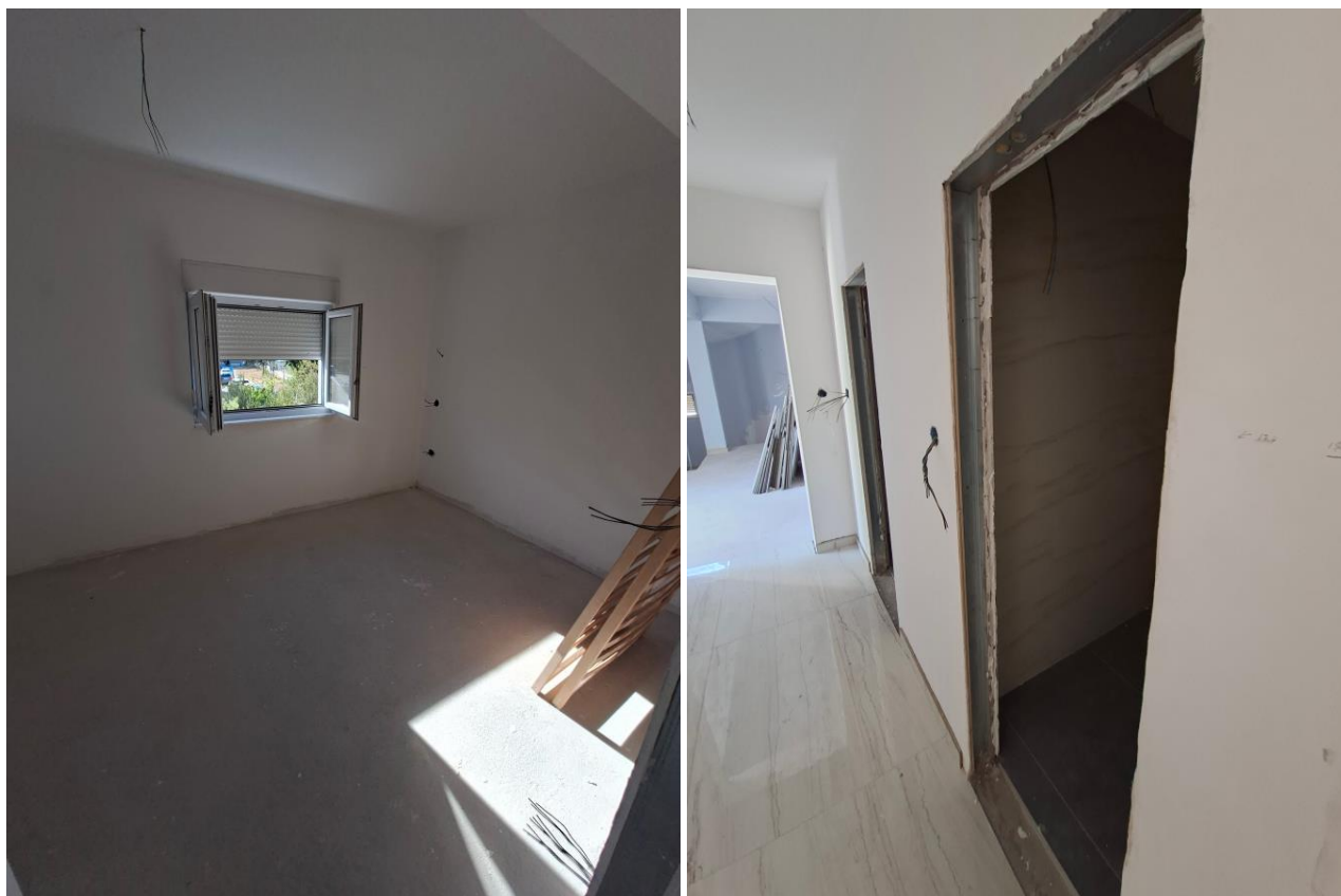
Fotografija 19 – unutrašnjost zgrade / 1. kat
