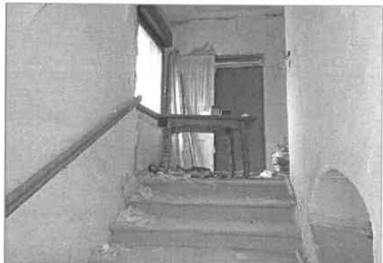
stubište za kat
