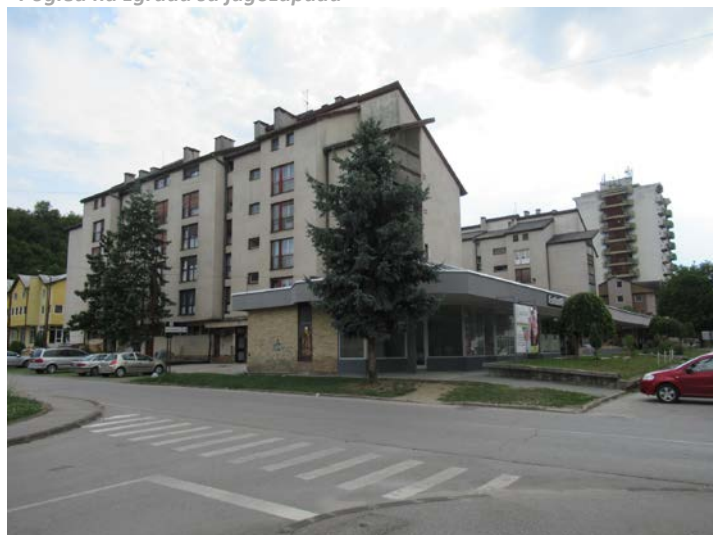
Pogled na zgradu sa sjeveroistoka
