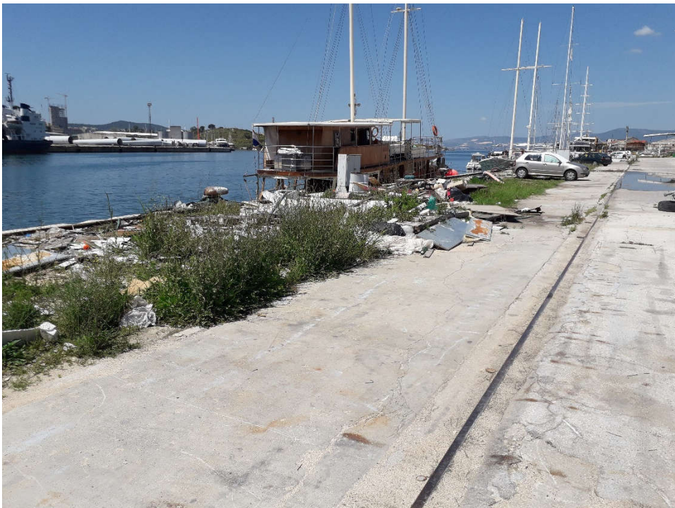
Slika 12. Sjeverna tračnica kranske staze uz kolosijek
