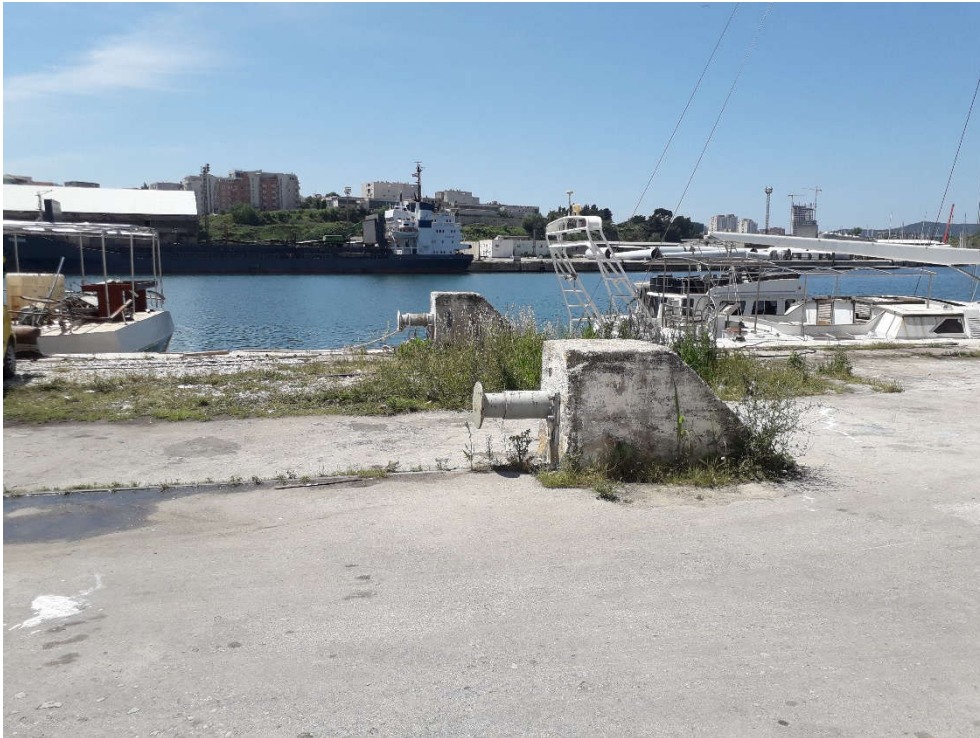
Slika 13. Betonski odbojnici kranske staze i kraj slijepog kolosijeka
