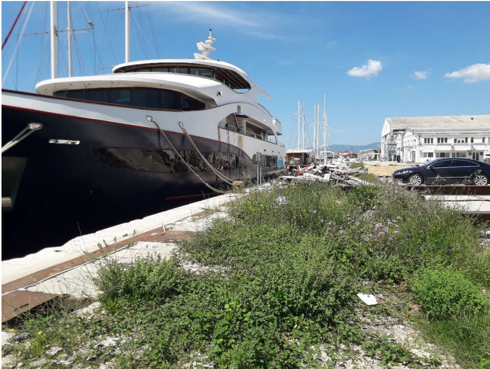
Slika 9. Kolosijek uz obalni zid, zarastao i prekriven zemljom, a južno uz obalu prolazi uz instalacijski kanal
