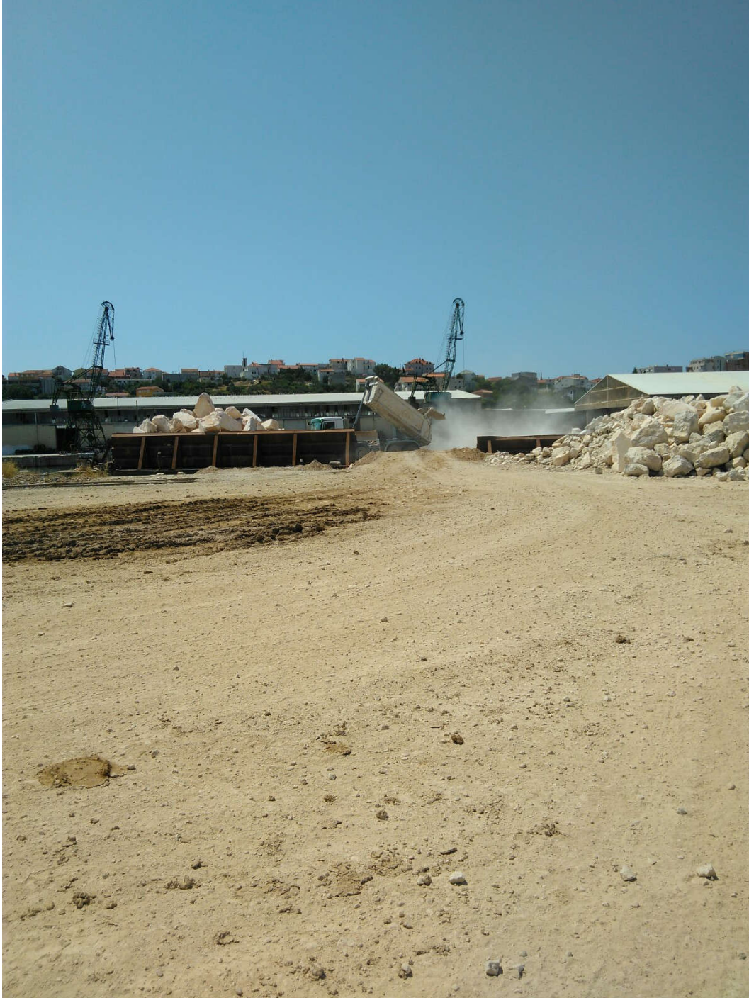
Slika 16. Dio kolosijeka preko kojeg je izveden makadamski plato i koristi se za prekrcaj kamena
