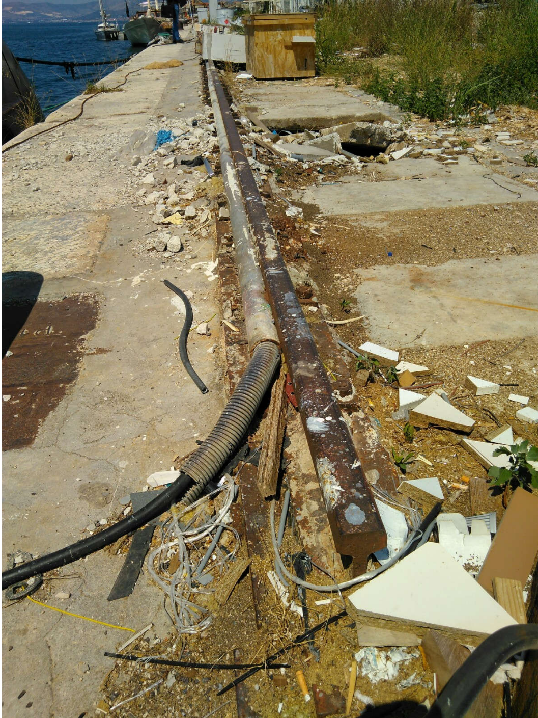
Slika 18. Preostali dio južne tračnice ktanske szaze s provučenim elektroinstalacijama
