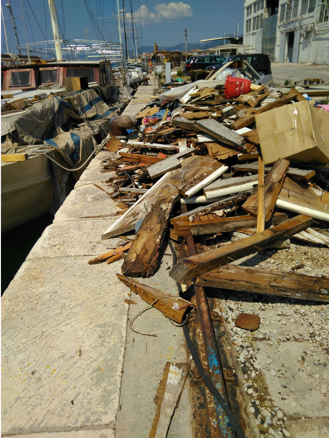
Slika 15. Otpad i brodska oprema na trasi kolosijeka
