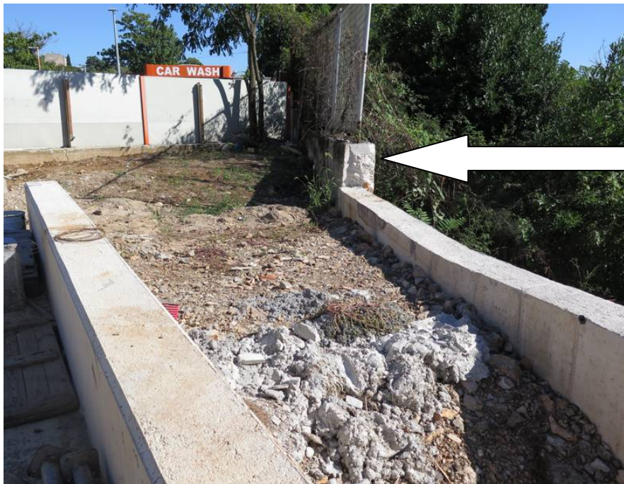
postojeći ogradni zida visine 150 cm do kote terena na južnoj strani
