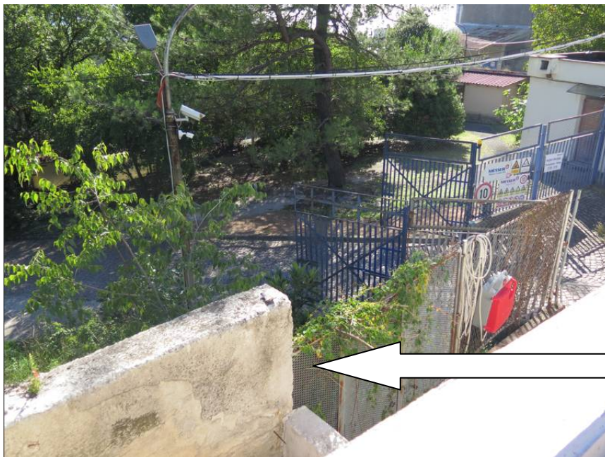
postojeći ogradni zida visine 300 cm do kote terena na južnoj strani
