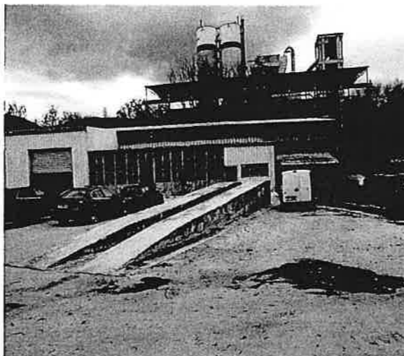
Slika 6 objekt „A“ servis
