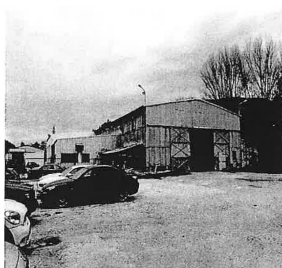
Slika 2 objekt „A“ servis
