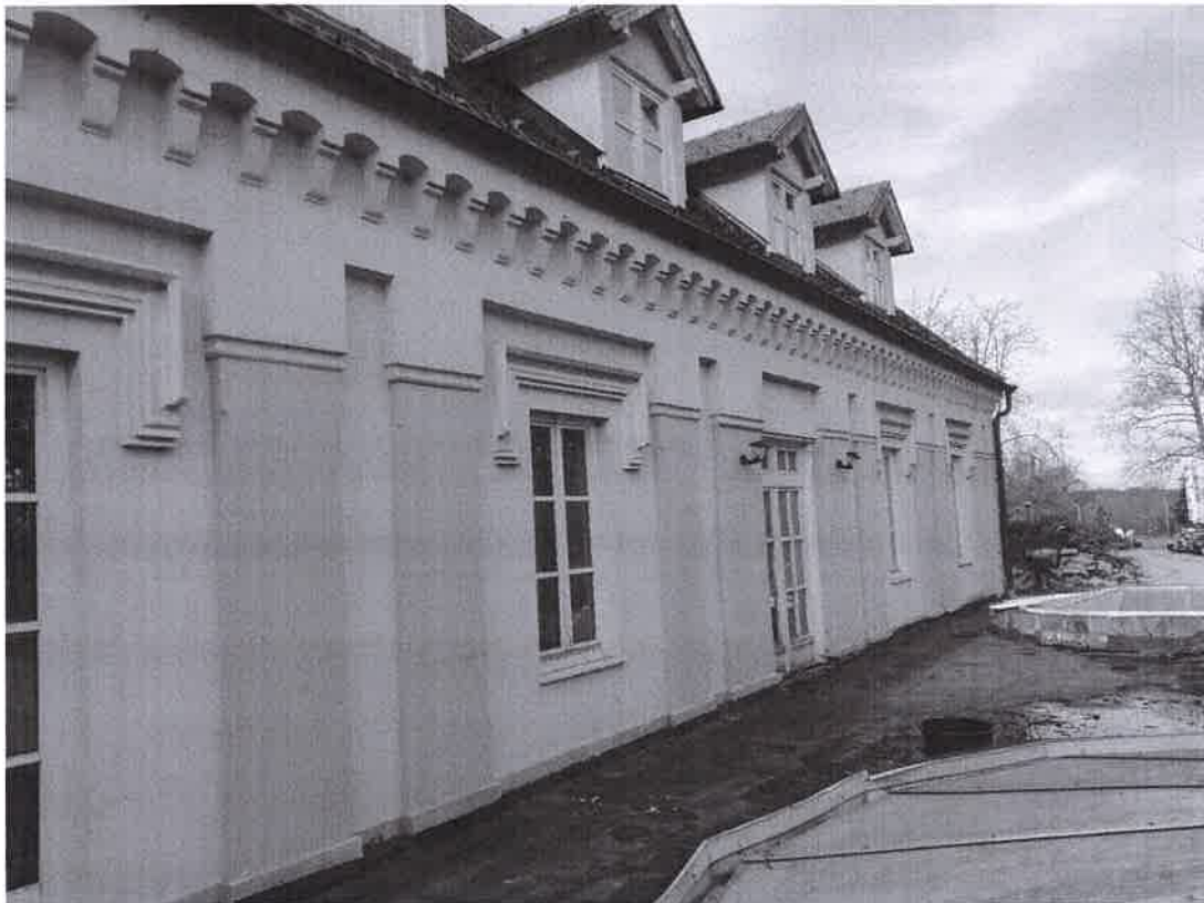
pročelje istok i krovna terasa aneksa br.1
