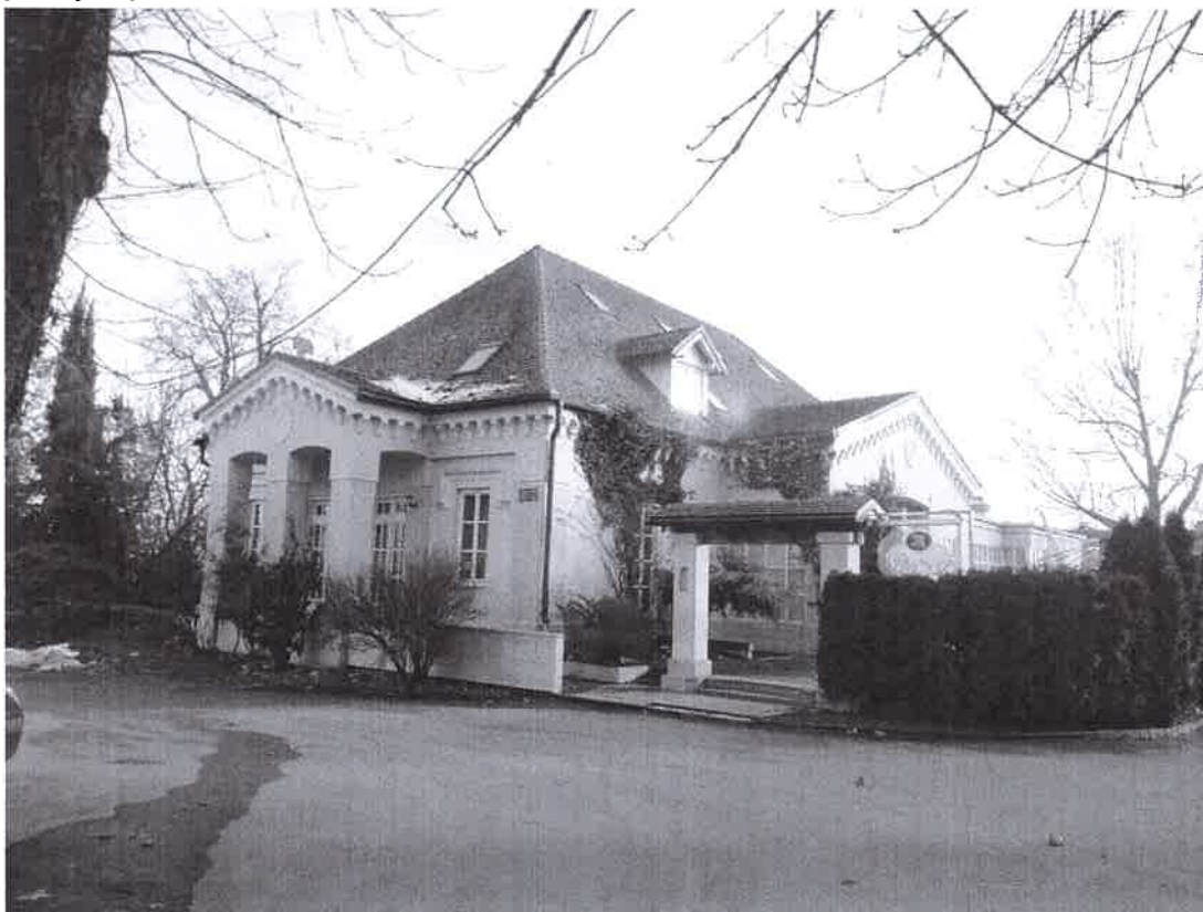
pročelje sjever i pročelje zapad
