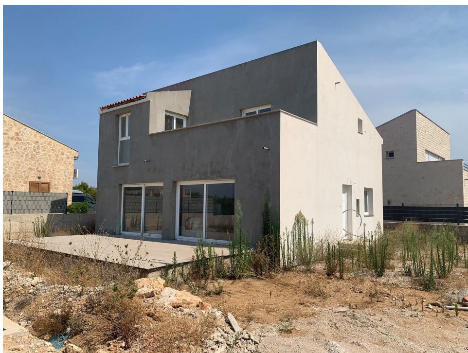
Fotografija 8 Pogled na dvorište prema susjednim objektima
