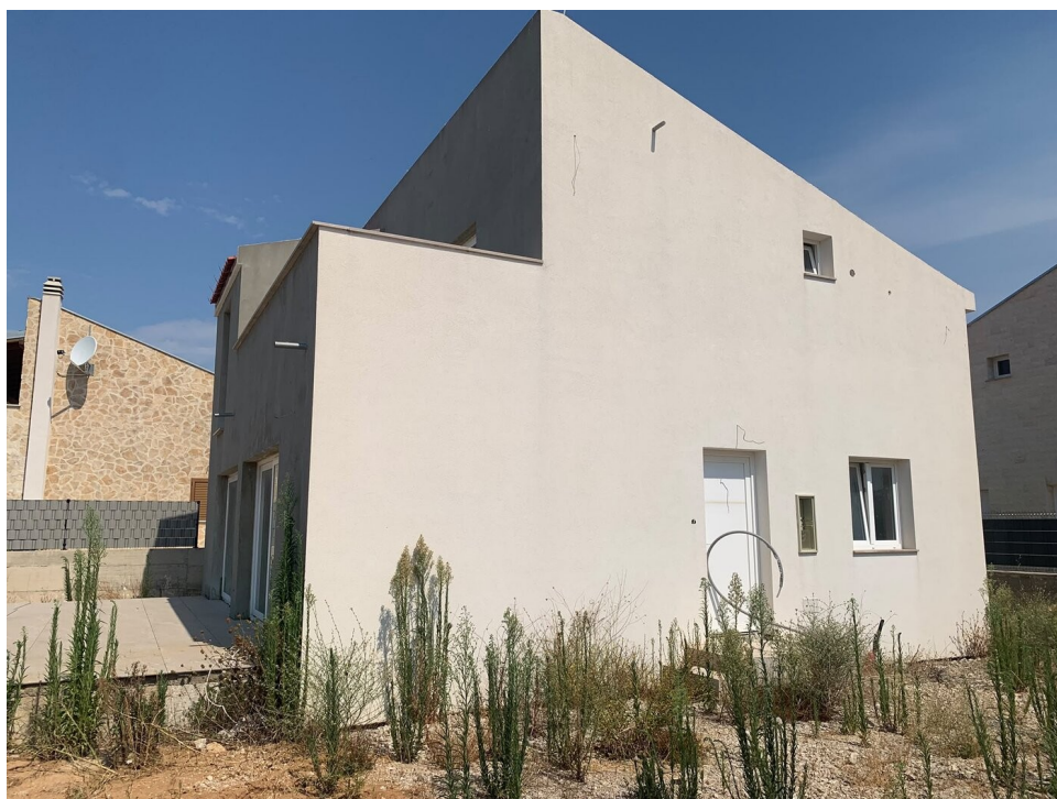
Fotografija 2 Bočno pročelje, vanjska stolarija ugrađena
