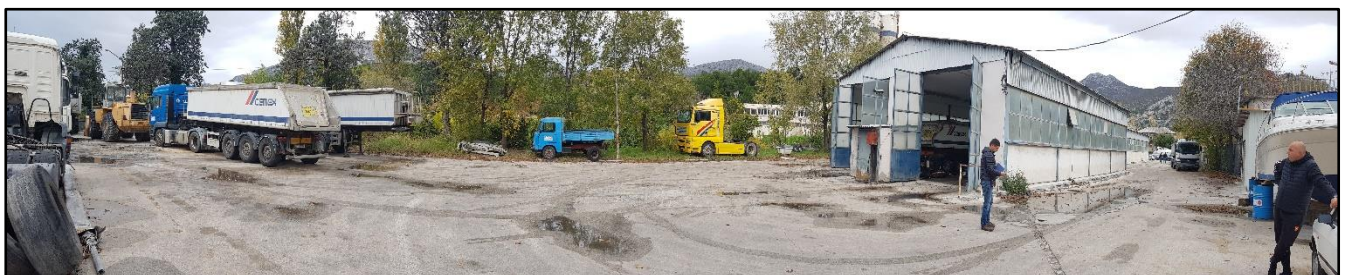
Panoramski izgled jugozapadnog dijela zemljišta i servisnog objekta
