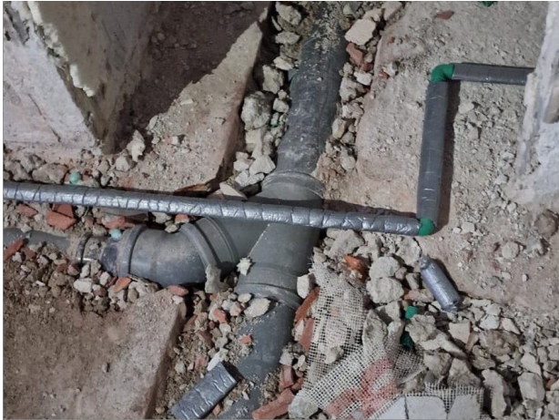
Foto 25. Polaganje odvodnje u pod
