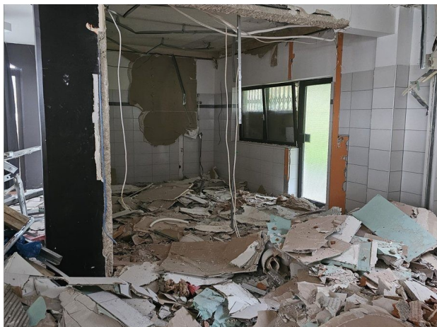
Foto 19. Rušenje stropova i pregrada
