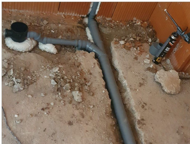
Foto 24. Razvod odvodnje u sanitarnom čvoru
