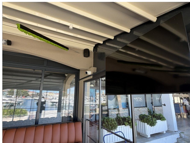
Foto 8. Sala – strop, rasvjeta i harmonika stijena
