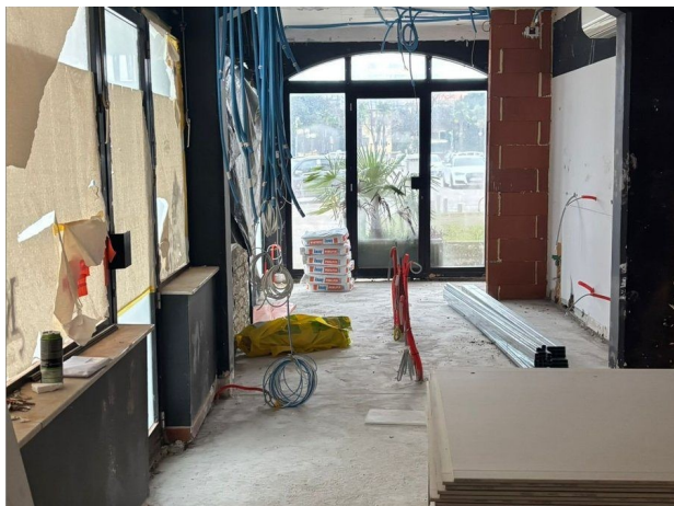
Foto 31. Elektroinstalacija po stropu
