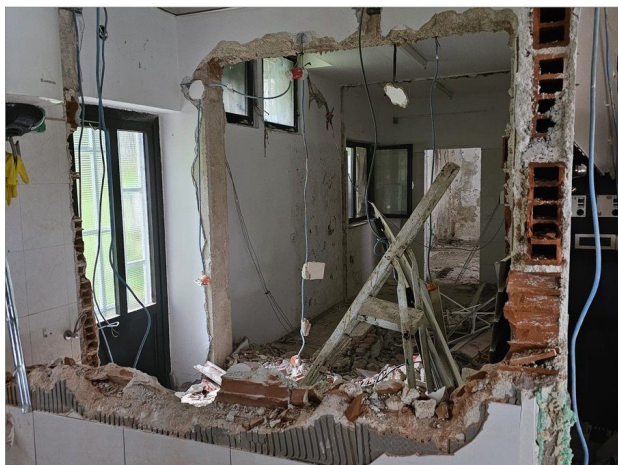
Foto 21. Rušenje zida u kuhinji
