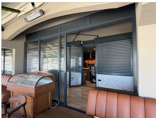
Foto 4. Pročelje – ostakljenje i ulazna vrata
