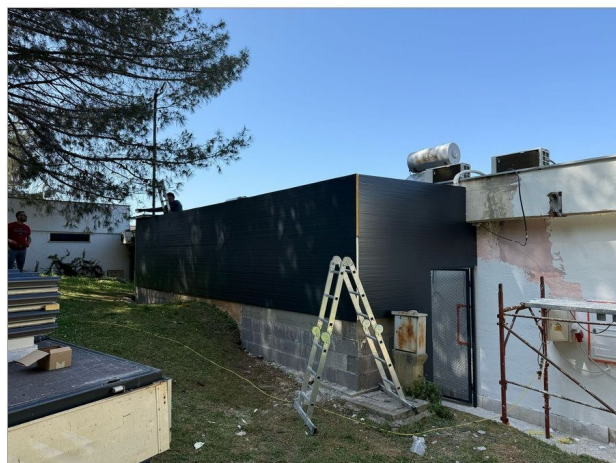
Foto 36. Stražnje pročelje – vanjske obloge u izvedbi
