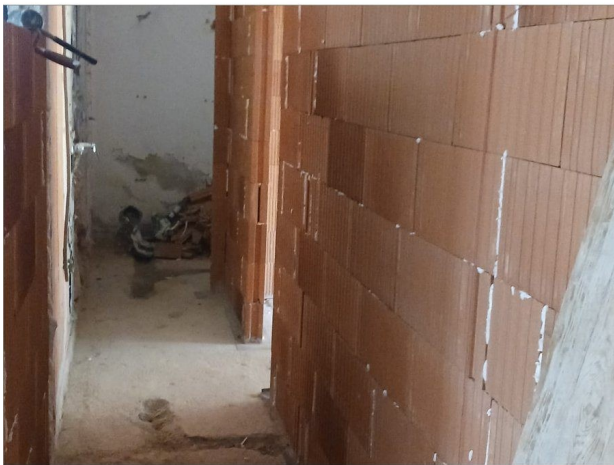
Foto 27. Zidanje pregradnih zidova opekom
