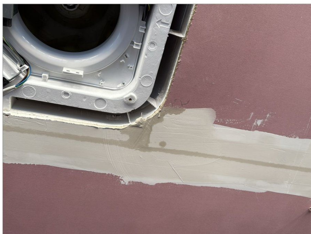
Foto 35. Gips-kartonski strop – ugradnja klima jedinice
