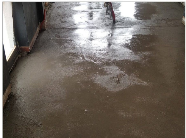
Foto 30. Cementna glazura u sali
