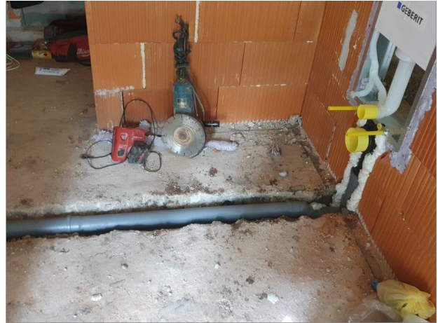
Foto 26. Odvodnja i vodovod uz pregradni zid
