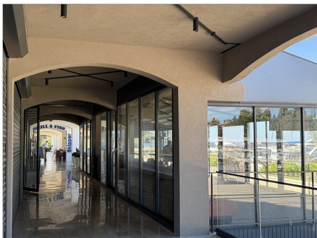
Foto 5. Natkriveni prolaz – ostakljenje pročelja
