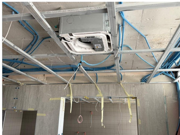
Foto 32. Potkonstrukcija spuštеноg stropa i klima jedinica
