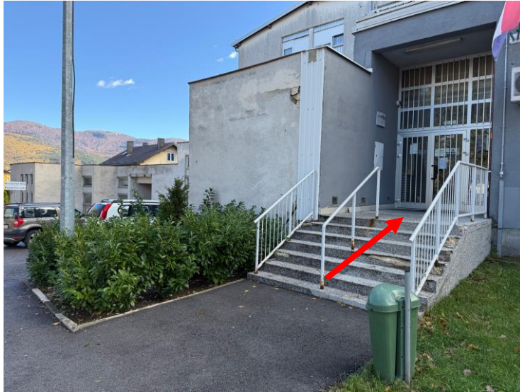
Fotografija 1 – ulaz u prostorije FINA-e, na sjeverozapadnom pročelju zgrade, Ulica Alojzija Stepinca kbr.2.
