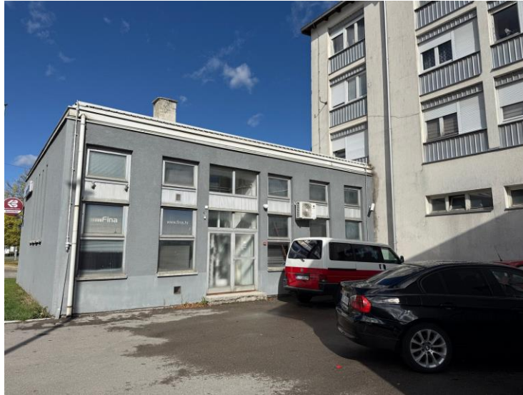
Fotografija 10 – asfaltirana površina oznake P3-parkiralište (pogled u smjeru sjeverozapada).
