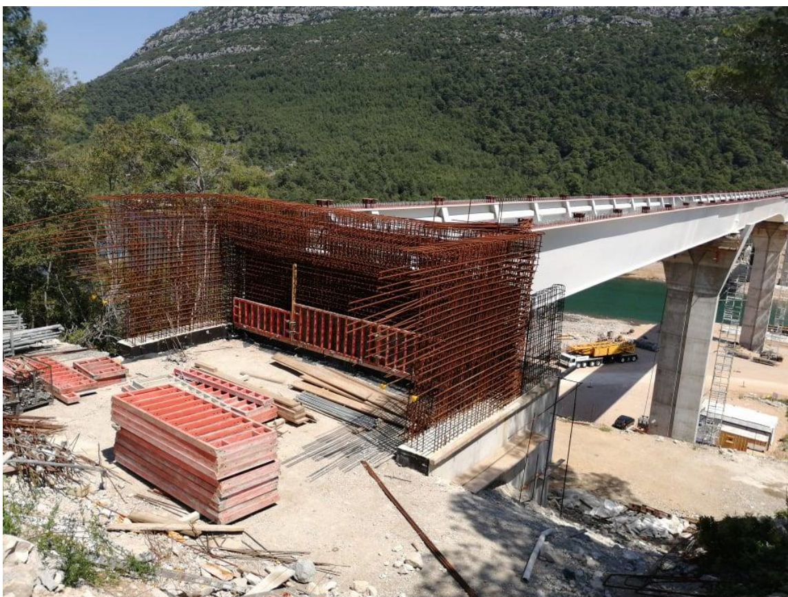
Prilog 1i - čelična konstrukcija rasponskog sklopa mosta Ston
