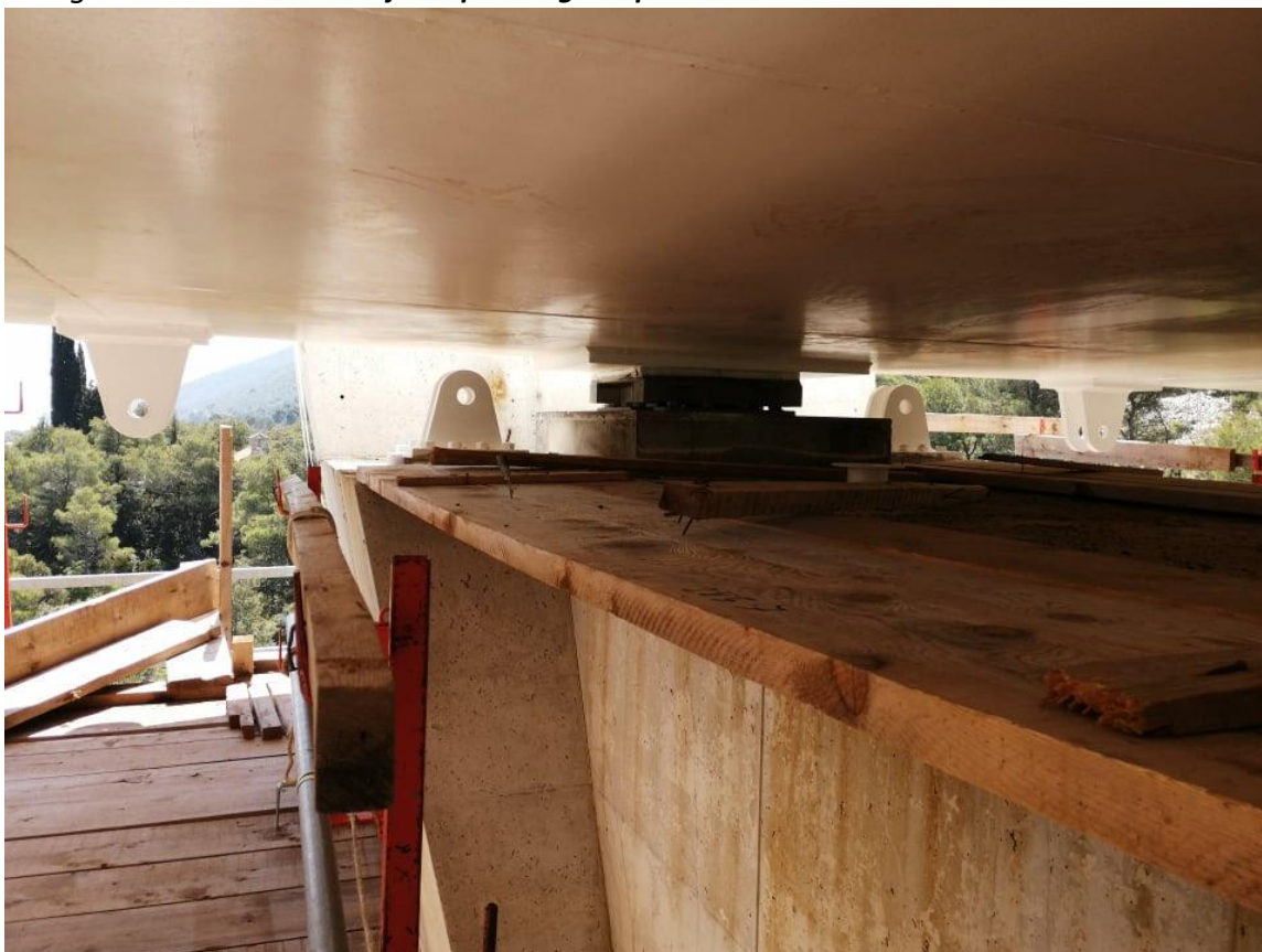
Prilog 1i - čelična konstrukcija rasponskog sklopa mosta Ston
