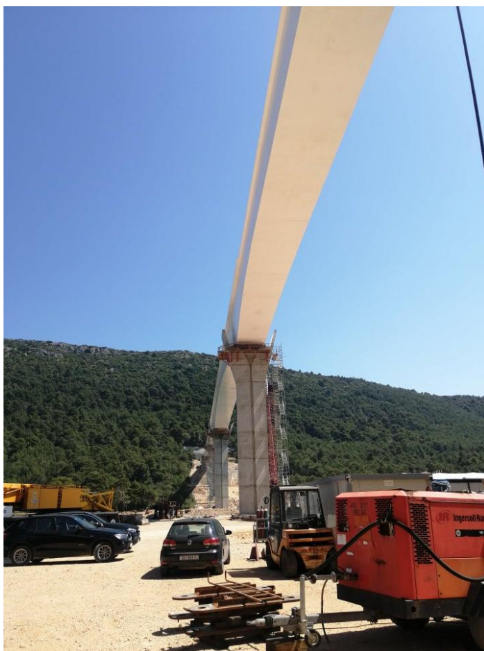
Prilog 1d - čelična konstrukcija rasponskog sklopa mosta Ston
