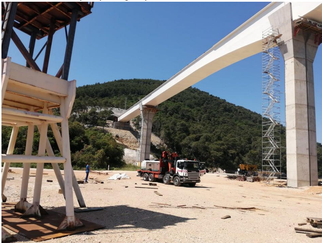
Prilog 1a - čelična konstrukcija rasponskog sklopa mosta Ston
