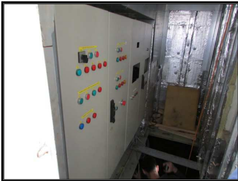
Slika 19. Glavna električna razvodna ploča
