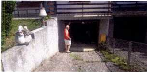
ulaz u garažu u podrumu
