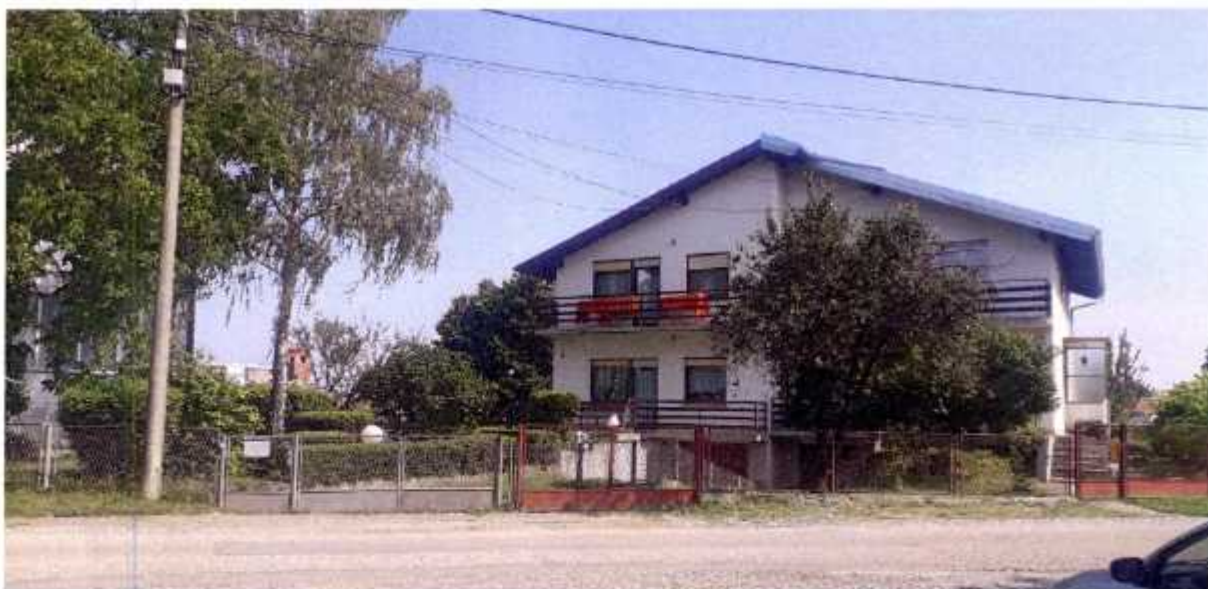
Obiteljska kuća Lomnička 13, velika Gorica – ulično pročelje
