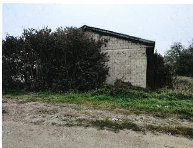
Slika 12: zgrada 2 – ulično pročelje
