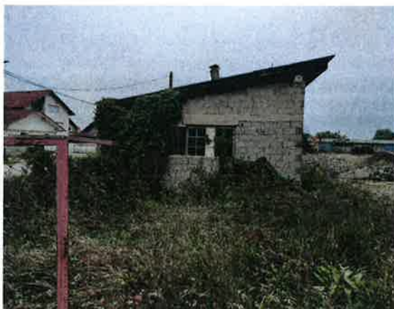
Slika 9: zgrada 1 – bočno pročelje
