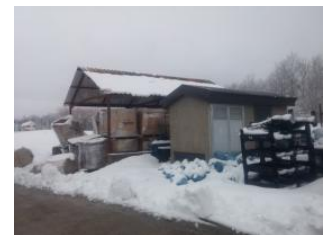
nadstrešnica i trafostanica
