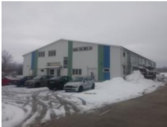
jugozapadno i jugoistočno pročelje
